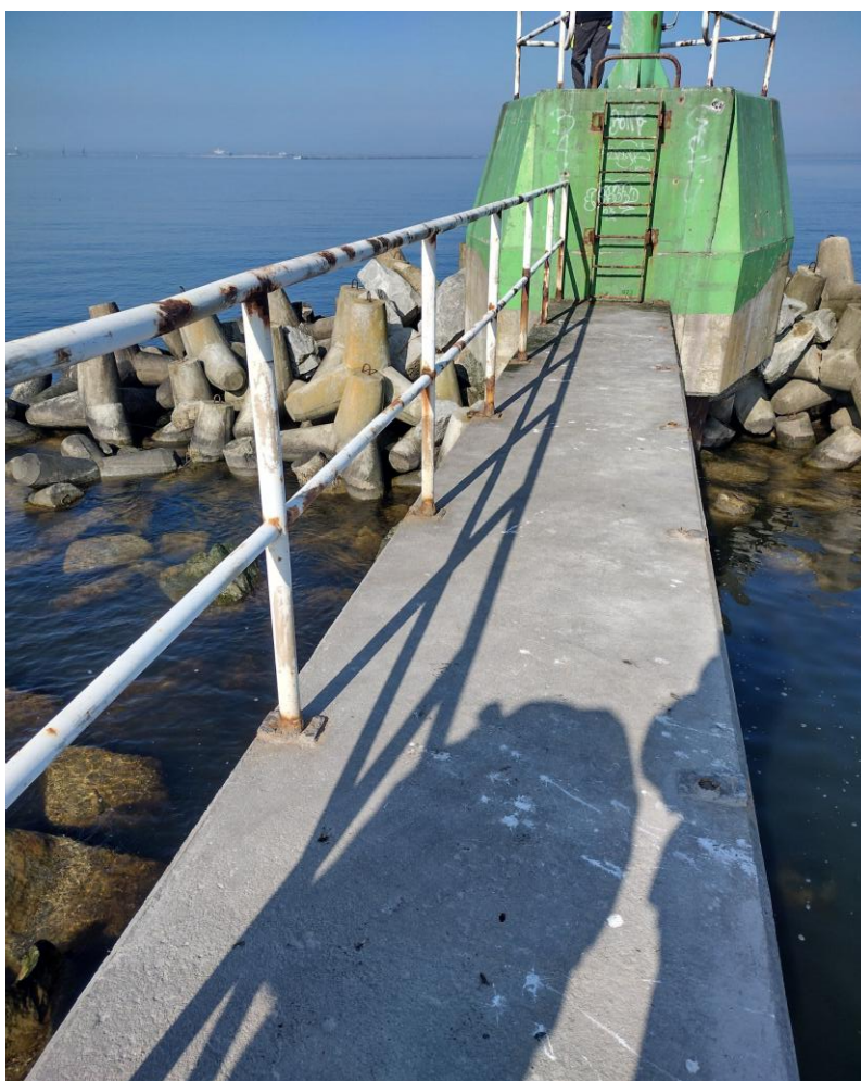
Rys.3. Betonowa kładka techniczna
