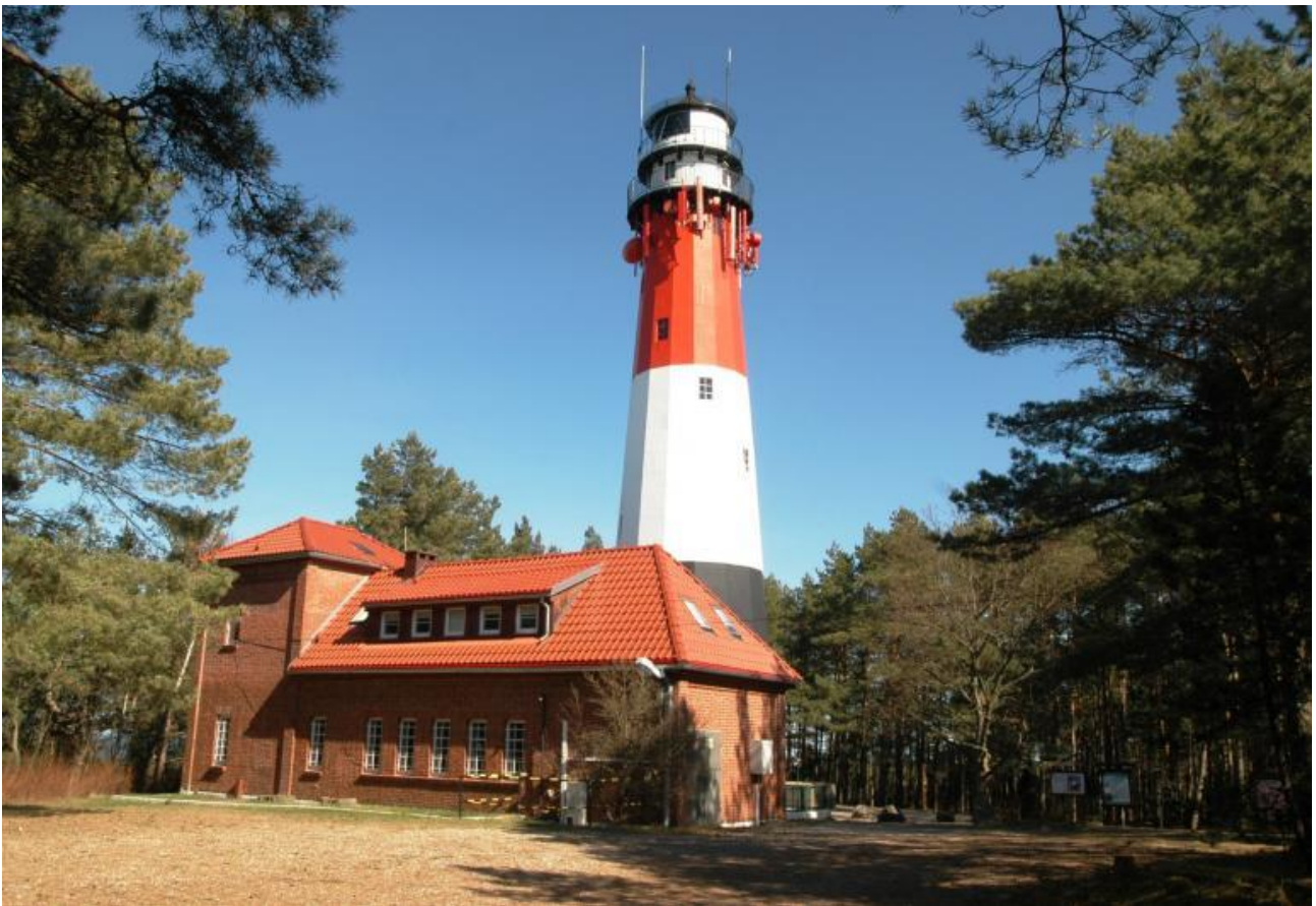
Rys. 1 Budynek maszynowni przy LM Stilo
