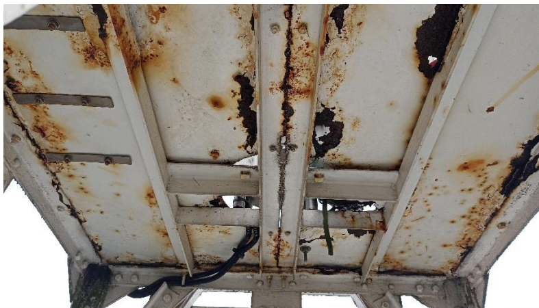
Rys. 3 Górny podest roboczy (widok od dołu)
