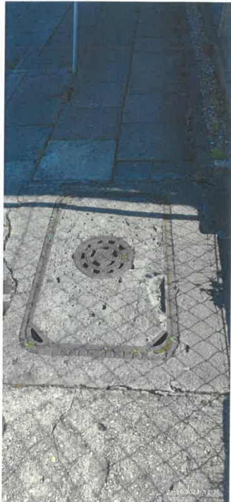
Zdj. 2 Zdjęcia włączenia projektowaną kanalizacją kablową do istniejącej studni teletechnicznej Urzędu Morskiego w Gdyni
