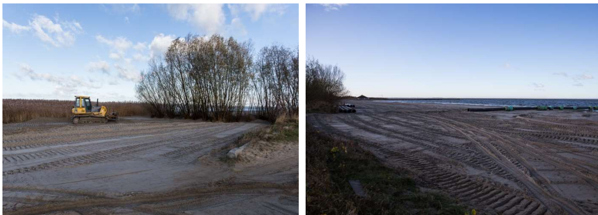
Fotografia 6.6. Refulacja prowadzona na plaży w Kadynach w listopadzie 2020 r. (fot. M. Michałek)
