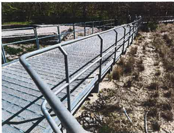
Odształcony od pierwotnej geometrii odcinek kładki.
