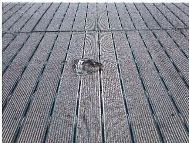
Kładka w stanie dobrym, pojedyncze elementy pokładu uszkodzone.
