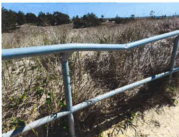
Miejscowe uszkodzenia balustrad.
