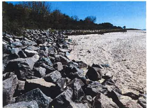
Umocnienie na odc. C ustabilizowane, bez widocznych ubytków i zniszczeń.
