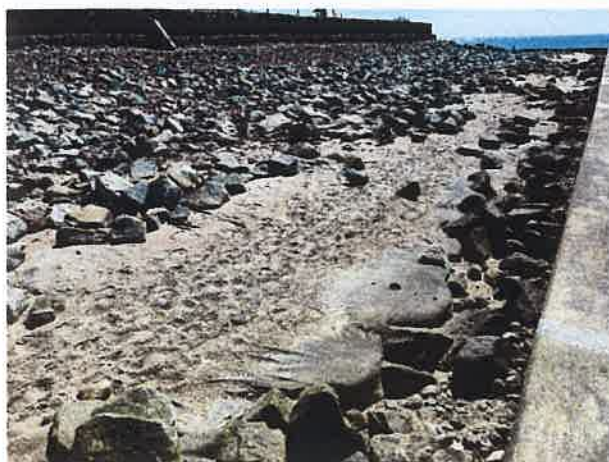
Zasyp filtracyjny odc. B silnie skonsolidowany, rzędna zasypu obniżona, miejscowo odkryta geowłóknina.
