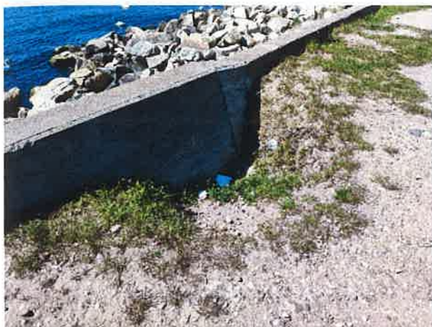
Ubytek zasypu za umocnieniem na odcinku typu A.
