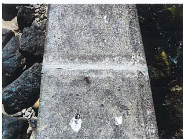
Dylatacje pomiędzy sekcjami umocnienia na odc. B wypełnione materiałem plastycznym.
