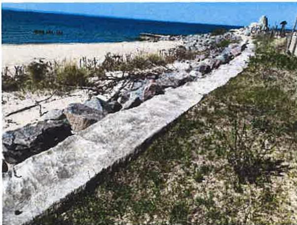
Umocnienie na odc. C ustabilizowane, bez widocznych ubytków i zniszczeń.
