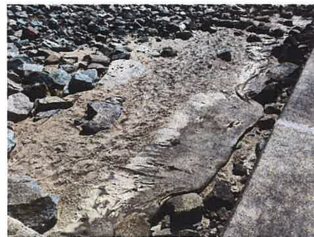
Zasyp filtracyjny odc. B silnie skonsolidowany, rzędna zasypu obniżona, miejscowo odkryta geowłóknina.
