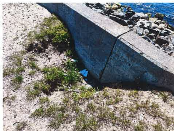
Ubytek zasypu za umocnieniem na odcinku typu A.
