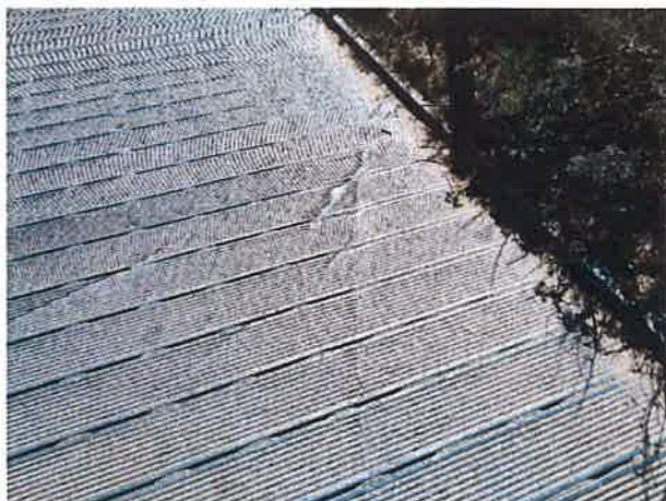
Kładka w stanie dobrym, pojedyncze elementy pokładu uszkodzone.
