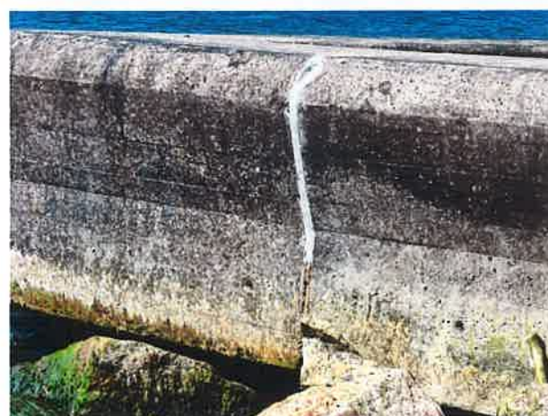
Dylatacje pomiędzy sekcjami umocnienia na odc. B wypełnione materiałem plastycznym.
