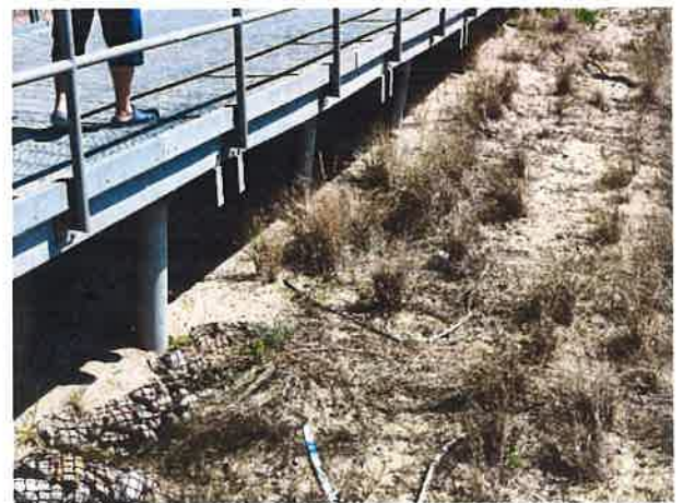
Odształcony od pierwotnej geometrii odcinek kładki.
