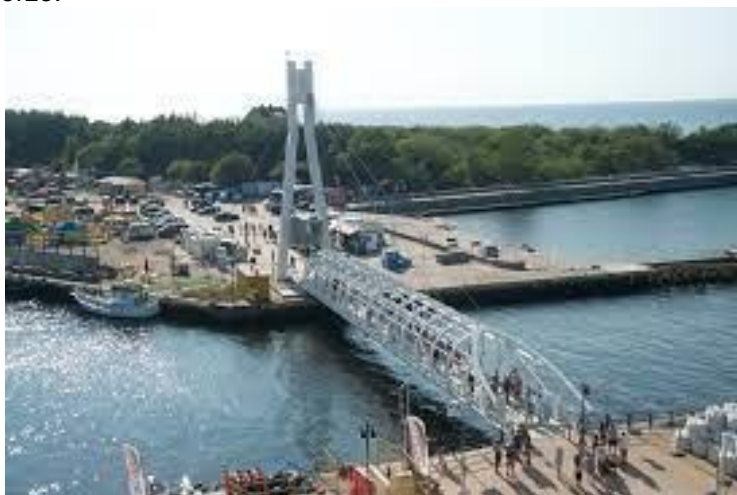
Fot. 1. Kładka piesza na terenie Portu Morskiego w Ustce
