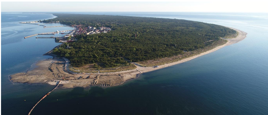
Ryc. 27. Zdjęcie z dokumentacji prac refulacyjnych 86 ;
