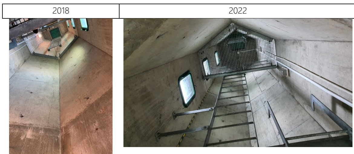
Fot. 6 Wnętrze latarni w dobrym stanie
