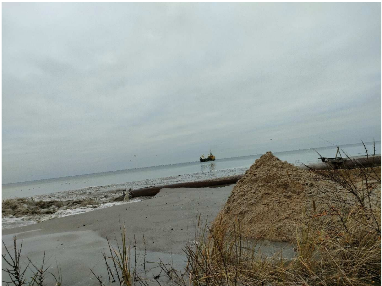
Rysunek 3 Wylot rurociągu lądowego i wydobywająca się z niego mieszanka wodno-gruntowa, pompowana z ładowni pogłębiarki, w tle pogłębiarka ssąco-nasiębierna Inż. Łęgowski
