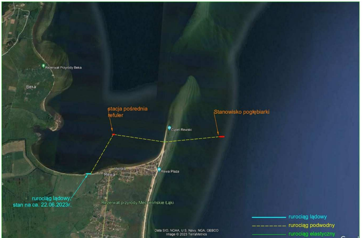
Rysunek 13 Refulacja Rewa etap II - prace w trakcie
