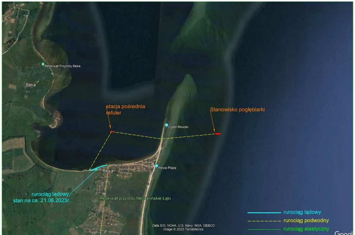
Rysunek 12 Refulacja Rewa etap II - prace w trakcie
