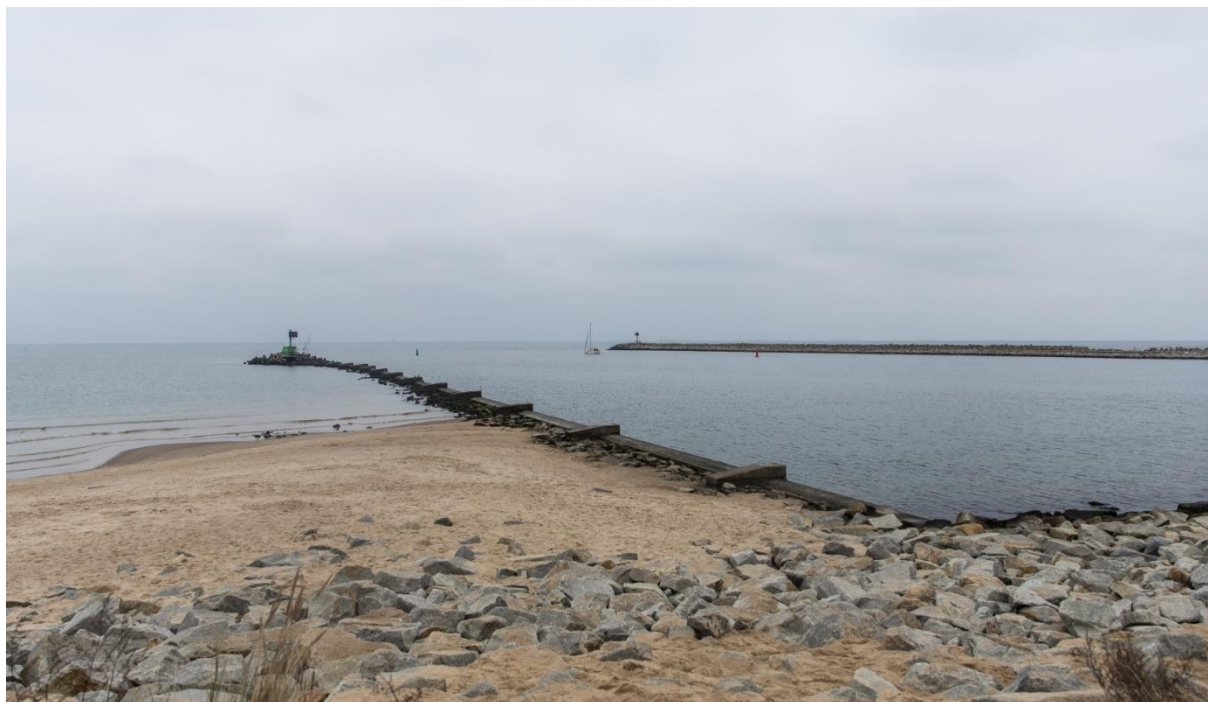
Zdjęcie przedstawia kierownice Ujścia Wisły wraz z narzutem kamiennym (archiwum Instytutu Morskiego)
