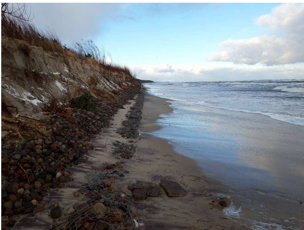
Fot. 5 Widok na umocnienie brzegowe pomiędzy wejściem 31 i 32.
