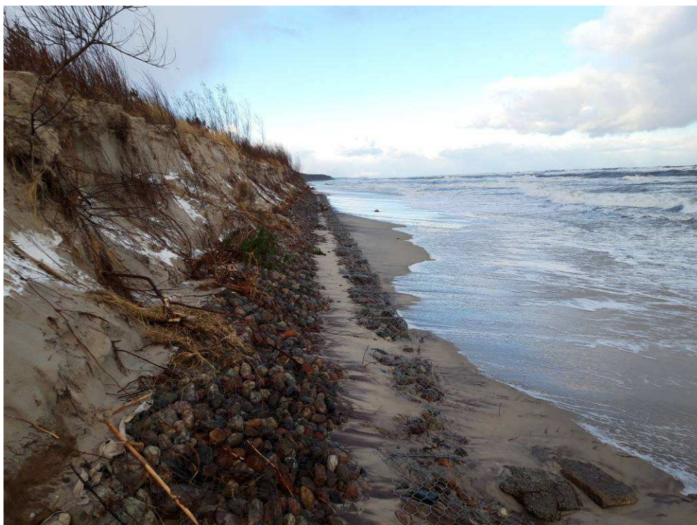
Fot. 4 Widok na umocnienie brzegowe pomiędzy wejściem 31 i 32.
