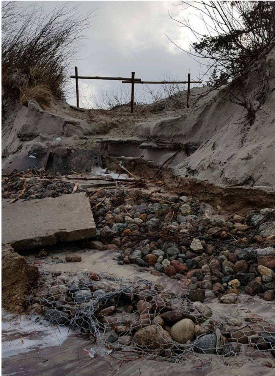
Fot. 3 Widok na zniszczone umocnienie brzegowe na odcinku niezaregulowanym.
