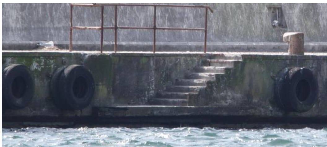
Ryc. 29. Występowanie zielenic w nieciągłych powierzchniach w części niektórych ścian pionowych nabrzeży wewnątrz projektowanego portu morskiego Hel – Zachód (fot. M. Marciniak)
