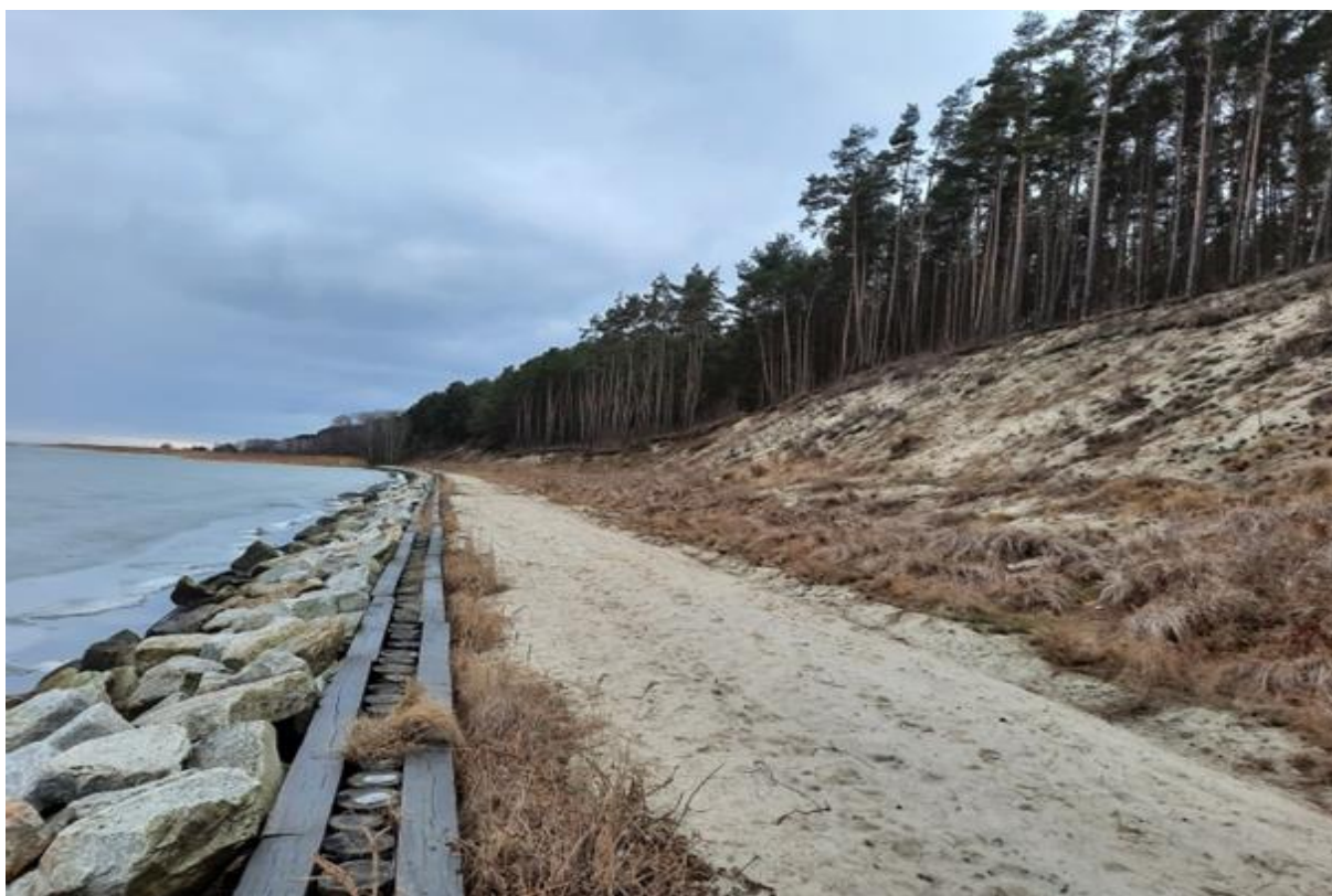
Fotografia 6.7. Opaska w rejonie Piasków. Na zapleczu stromy klif wydmowy, styczeń 2021 r. (fot. H. Boniecka)
