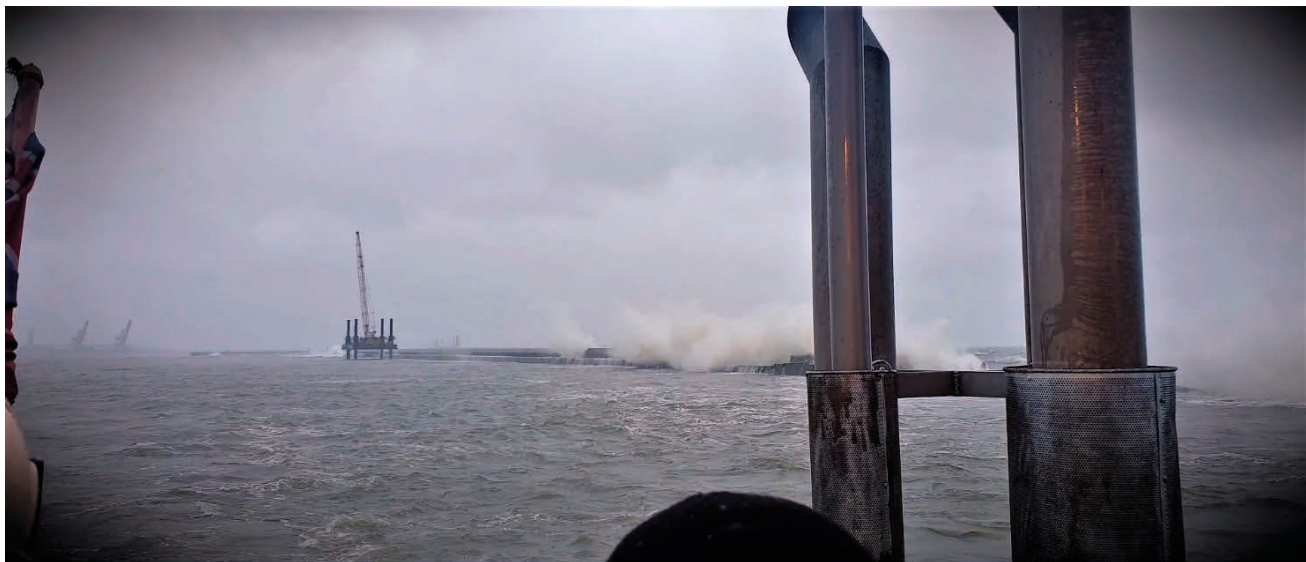
Rys. 41. Sztorm, wydłużany falochron, wodny plac budowy 14 października 2020 roku (fot. Łukasz Małkiewicz)
