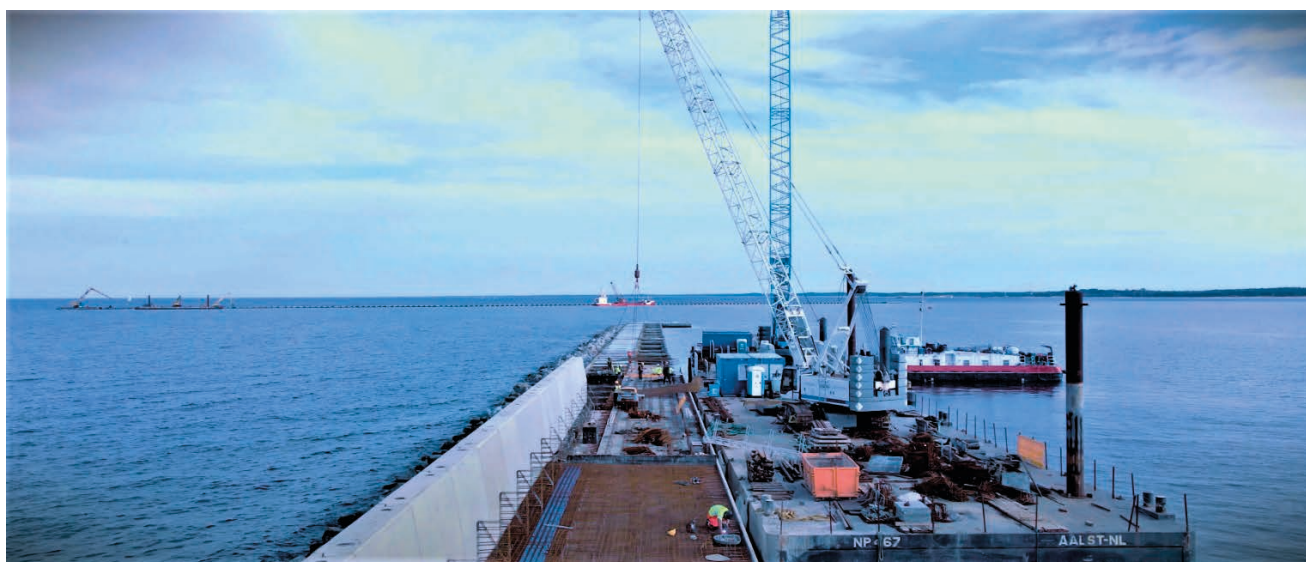
Rys. 33. Roboty żelbetowe, wydłużany falochron, wodny plac budowy, 5 października 2020 roku (fot. Łukasz Małkiewicz)
