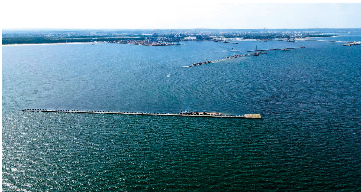
Rys. 14. Port Północny, widok z kierunku północno-wschodniego, od strony nowego falochronu wyspowego 14 sierpnia 2020 (fot. Łukasz Malkiewicz)
