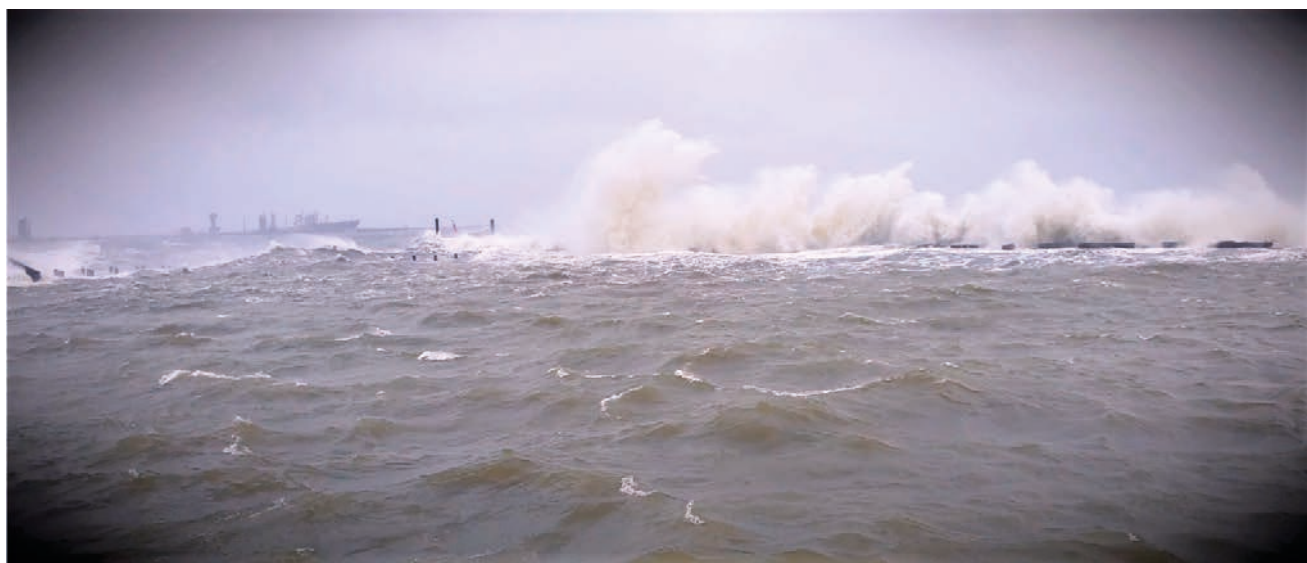
Rys. 40. Sztorm, wydłużany falochron, wodny plac budowy, 14 października 2020 roku (fot. Łukasz Małkiewicz)
