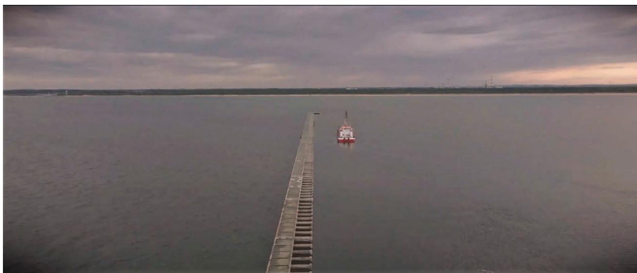
Rys. 39. Roboty narzutowe, nowy falochron, wodny plac budowy, 5 października 2020 roku (fot. Łukasz Małkiewicz)
