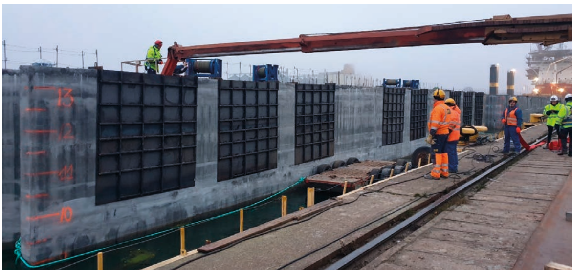
Rys. 9. Przygotowania pierwszej skrzyni typowej wydłużenia do przeholowania w miejsce wbudowania, duża prefabrykacja, nabrzeże Kaszubskie, 25 Listopada 2019 roku (fot. Łukasz Małkiewicz)
