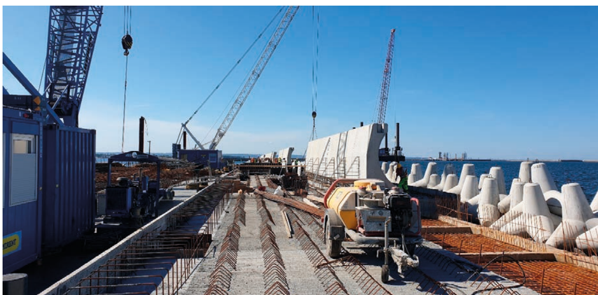
Rys. 13. Roboty żelbetowe, nadbudowa, wydłużany falochron, wodny plac budowy, 12 sierpnia 2020 roku, od lewej prefabrykat licowy U-kształtny (belka stropowa okna wygaszacza falowania), pośrodku L-kształtny prefabrykat stropu wygaszacza falowania, po prawej prefabrykat łamacza fal (fot. Łukasz Małkiewicz)
