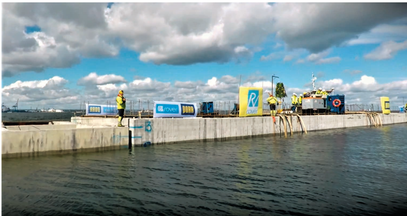
Rys. 16. Zakończenie ustawiania skrzyń, nowy falochron wyspowy, wodny plac budowy, 6 września 2020 roku (fot. Łukasz Małkiewicz)
