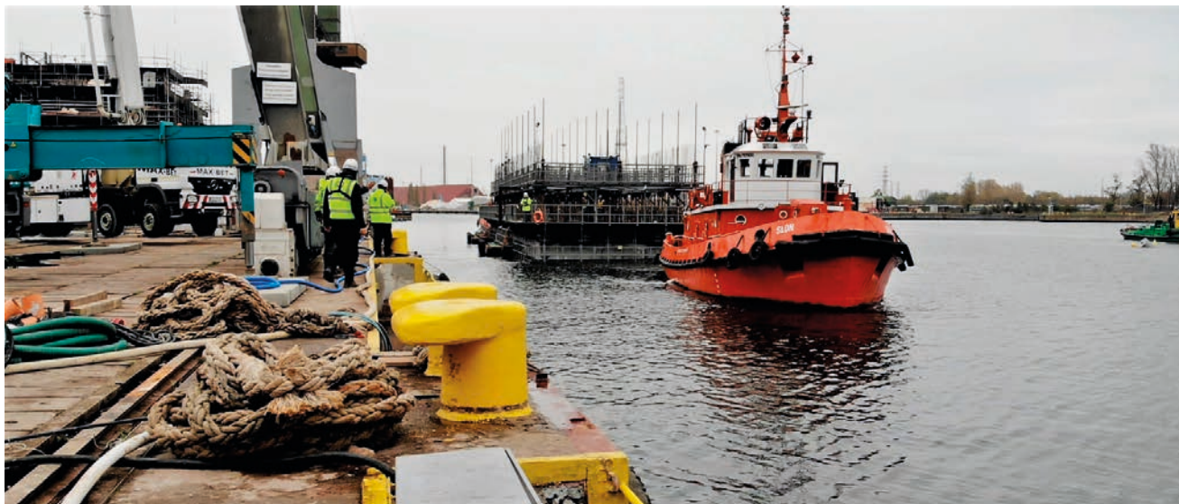
Rys. 32. Ustawienie skrzyni do drugiej fazy betonowania ścian, nabrzeże Kaszubskie, duża prefabrykacja, 19 października 2019 roku (fot. Łukasz Małkiewicz)
