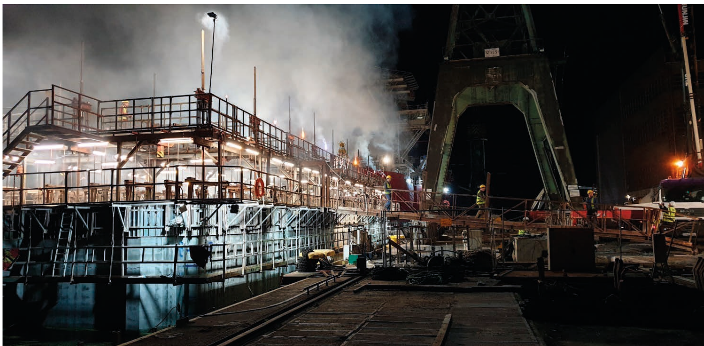
Rys. 15. Zakończenie prefabrykacji skrzyń, duża prefabrykacja, nabrzeże Kaszubskie, 29 sierpnia 2020 roku (fot. Łukasz Małkiewicz)
