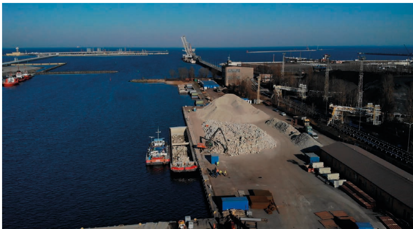
Rys. 5. Główne zaplecze budowy – Port Północny, basen roboczy, nabrzeże Południowe, 25 marca 2020 (fot. Łukasz Małkiewicz)
