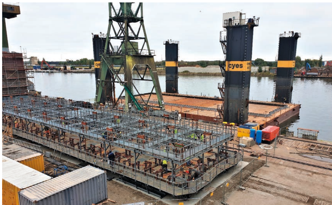
Rys. 22. Premontaż szalunku ślizgowego skrzyni typowej wydłużenia, nabrzeże Kaszubskie, duża prefabrykacja, 23 września 2019 roku (fot. Łukasz Małkiewicz)
