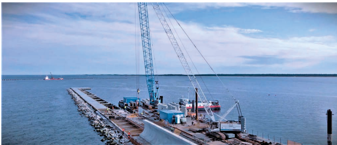
Rys. 34. Roboty żelbetowe, wydłużany falochron, wodny plac budowy, 5 października 2020 roku (fot. Łukasz Małkiewicz)
