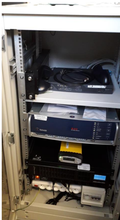
Fot. 2 Rack UMG - stacja AIS , gniazda AC, zasilanie UPS, miejsce montażu modułu VDES
