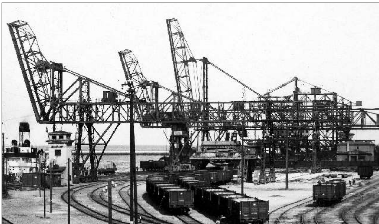
Fragment portu w Gdyni. Rozjazd torów kolejowych na Nabrzeże Węglowe. A part of the port in Gdynia. The railroad switch to the Coal Quay.
