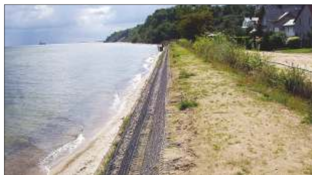
Mechelinki. Korona opaski brzegowej. The top of the seawall in Mechelinki.
