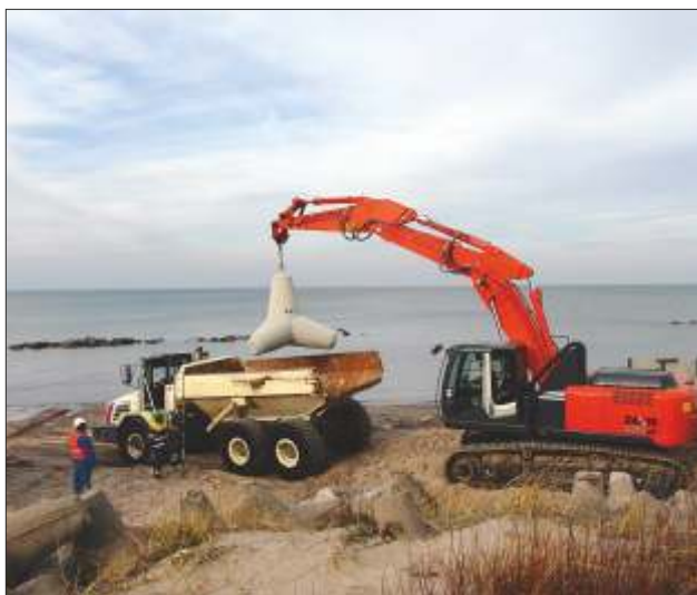
Ochrona brzegu morskiego na wschód od portu w Darłowie. Odbudowa falochronów brzegowych oraz zespołu ostróg. Coastal protection to the east of the port in Darłowo. Reconstruction of breakwaters and groyens.
