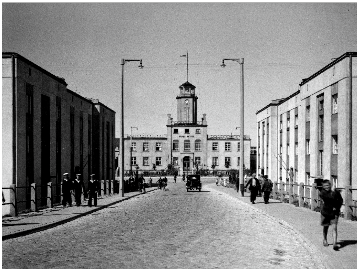
Urząd Morski w Gdyni na ul. Centralnej (obecnie Chrzanowskiego) w 1935 roku. The Maritime Office in Gdynia on Centralna street (currently Chrzanowski street), 1935.
