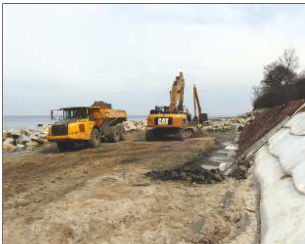
Ochrona brzegu morskiego na wschód od portu w Darłowie. Odbudowa falochronów brzegowych oraz zespołu ostróg. Coastal protection to the east of the port in Darłowo. Reconstruction of breakwaters and groyens.
