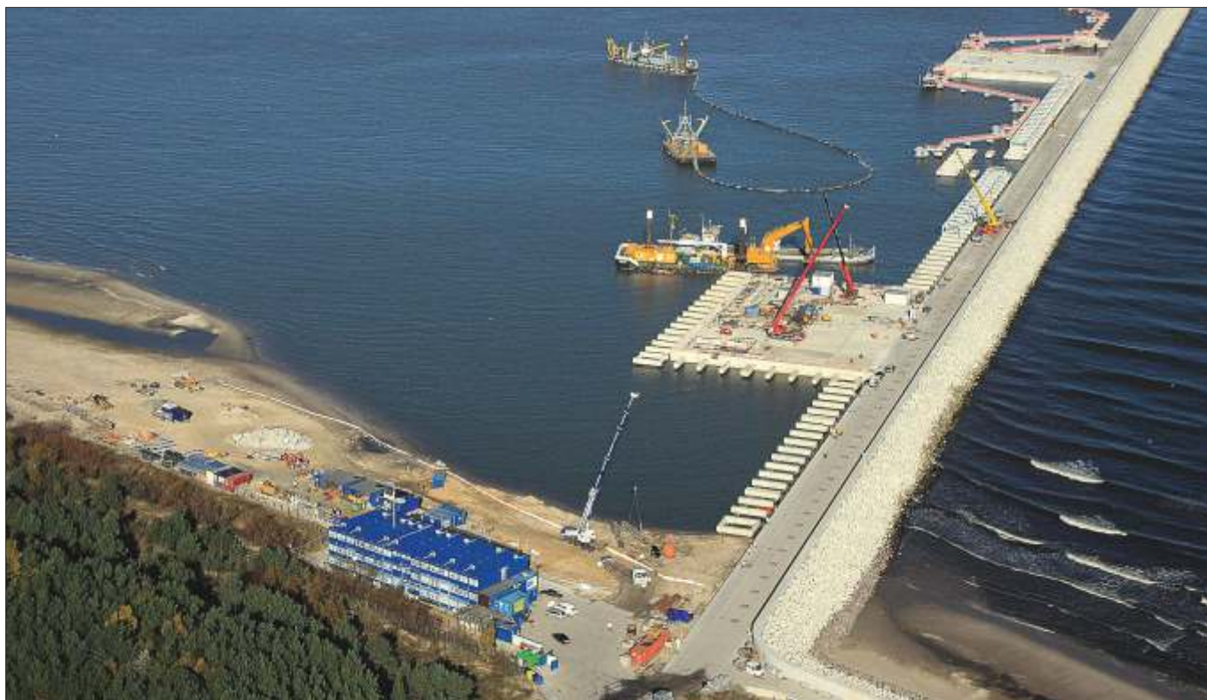
Budowa falochronu osłonowego dla gazoportu w Świnoujściu. The construction of the breakwater for the LNG terminal in Świnoujście.
