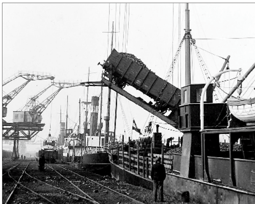
Praca wywrotnicy wagonów na Nabrzeżu Szwedzkim. Największymi odbiorcami polskiego czarnego złota były kraje skandynawskie. A wagon tippler at work on the Swedish Quay. The main receivers of Polish black gold are the Scandinavian countries.
