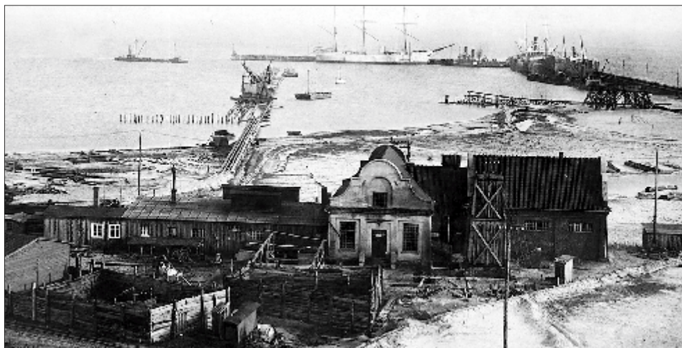
Rok 1925. Tymczasowy Port Wojenny i Schronisko dla Rybaków. Widać początek budowy Nabrzeża Węglowego. 1925. The beginning of construction of the Temporary Naval Base and the Shelter for Fishermen and the Coal Quay.
