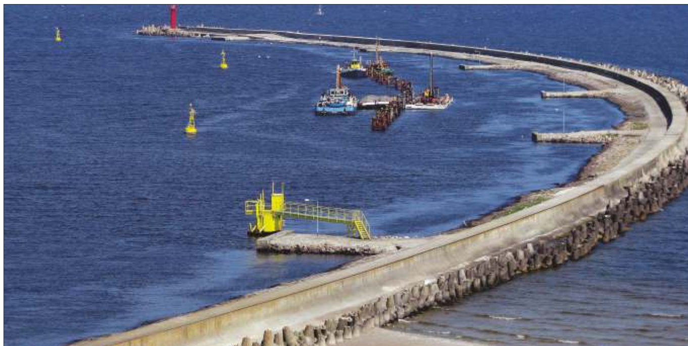
Falochron wschodni po przebudowie stał się centralnym i zwiększył bezpieczeństwo portów. The rebuild eastern breakwater, now called the central, after the rebuild increased the safety of the ports.
