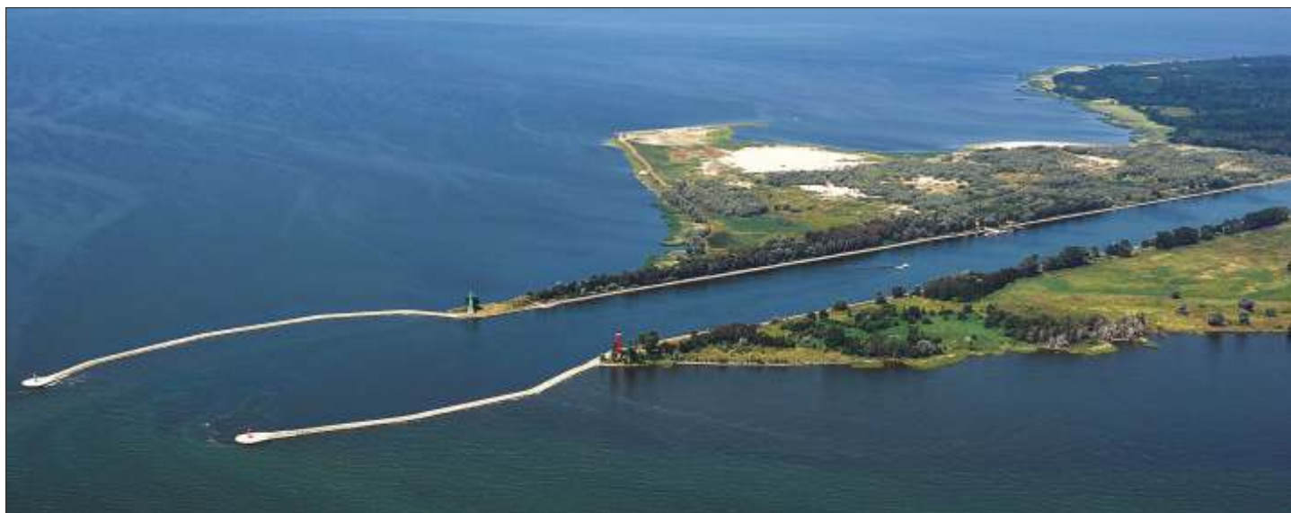
Tor wodny Świnoujście-Szczecin. Tu Kanał Piastowski łączy się z Zalewem Szczecińskim. The Świnoujście-Szczecin fairway. Here the Piast Canal meets the Szczecin Lagoon.
