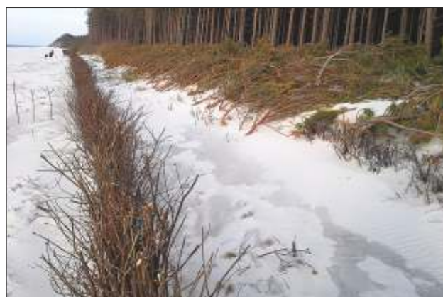
Stilo. Posadzony płotek wydmowy i wyłożony chrust. Planted dune fence with brushwood in Stilo.
