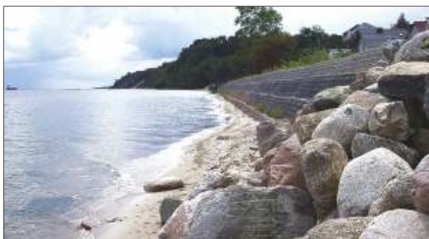
Mechelinki. Opaska brzegowa. The gabion seawall in Mechelinki.
