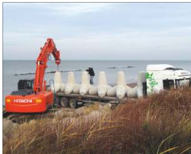
Ochrona brzegu morskiego na wschód od portu w Darłowie. Odbudowa falochronów brzegowych oraz zespołu ostróg. Coastal protection to the east of the port in Darłowo. Reconstruction of breakwaters and groyens.
