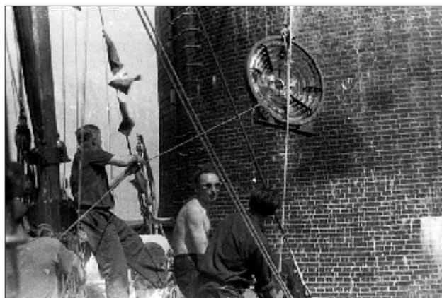
Brama torowa nr 2 na torze wodnym Świnoujście-Szczecin. Demontaż optyki przez załogę kutra hydrograficznego „Stenia”. The beacon number 2 on the fairway Świnoujście-Szczecin. The crew of the hydrographic cutter "Stenia" disassembles the optic.
