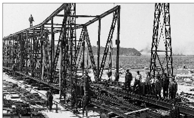
Montaż pierwszych dźwigów na Nabrzeżu Szwedzkim. Installation of the first cranes on the Swedish Quay.
