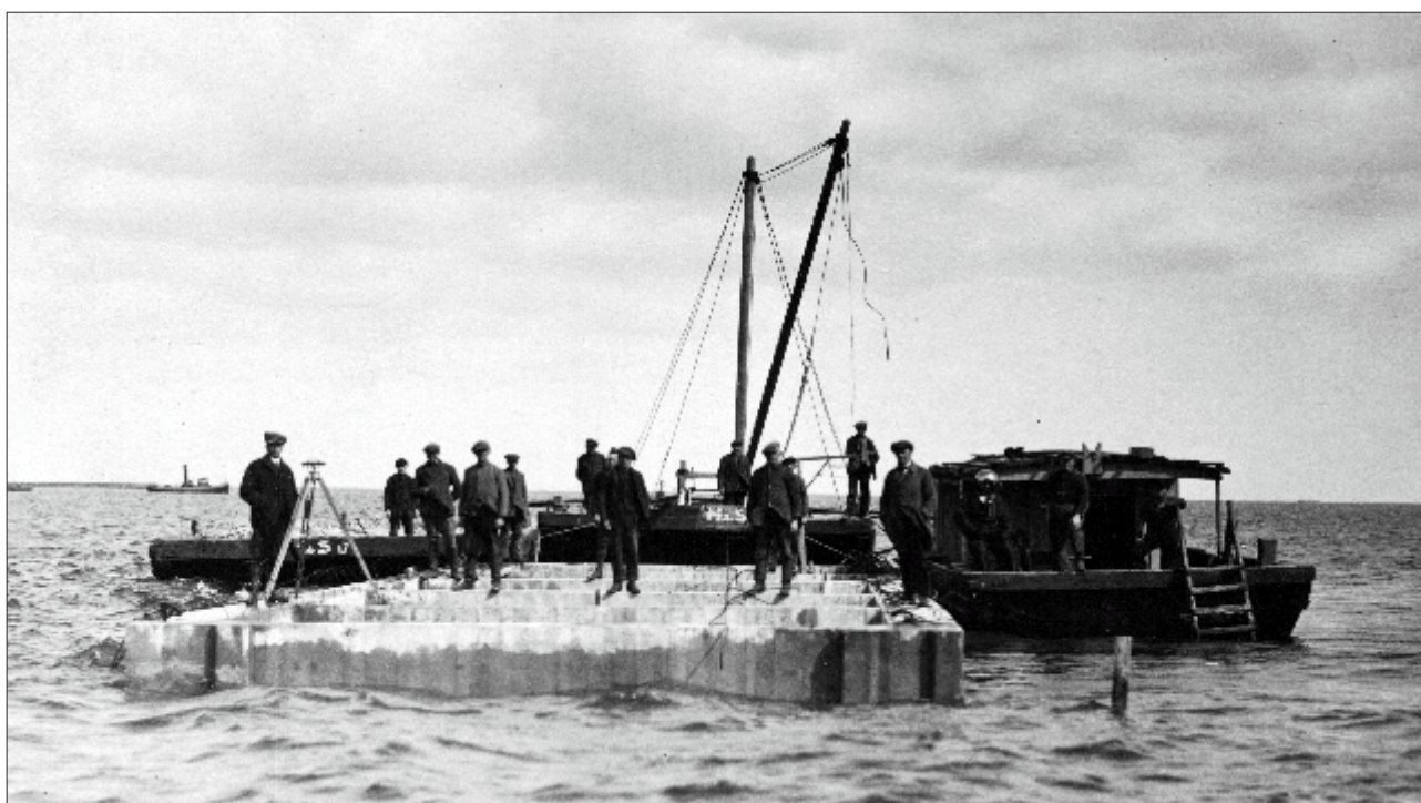
Robotnicy na zatopionym kesonie wyznaczającym linię przyszłego nabrzeża w gdyńskim porcie. Workers on an underwater caisson showing the line of the future quay of the port of Gdynia.
