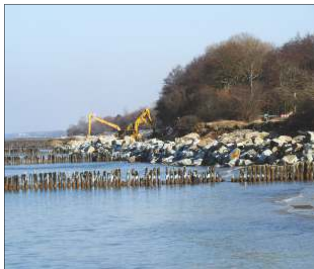
Ochrona brzegu morskiego na wschód od portu w Darłowie. Odbudowa falochronów brzegowych oraz zespołu ostróg. Coastal protection to the east of the port in Darłowo. Reconstruction of breakwaters and groyens.
