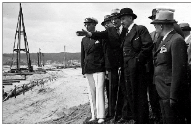
Eugeniusz Kwiatkowski z delegacją rządową i przedstawicielami Urzędu Morskiego w Gdyni na budowie portu. Eugeniusz Kwiatkowski, together with a government delegation and representatives of the Maritime Office in Gdynia, visiting the construction of the port.
