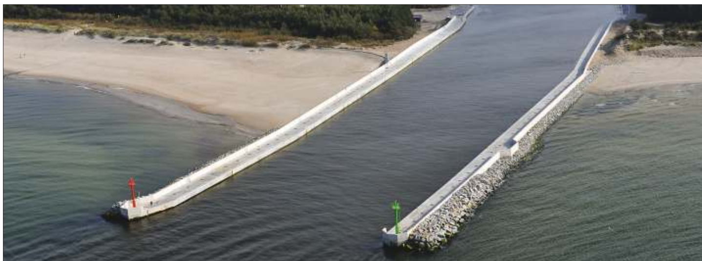
Przebudowane wejście do portu w Dziwnowie. Jeden z etapów projektu obejmującego pogłębianie toru podejściowego i basenu portowego, przebudowę falochronów i nabrzeży, modernizację portu rybackiego oraz zabezpieczenie brzegu i powiększenie plaży.
