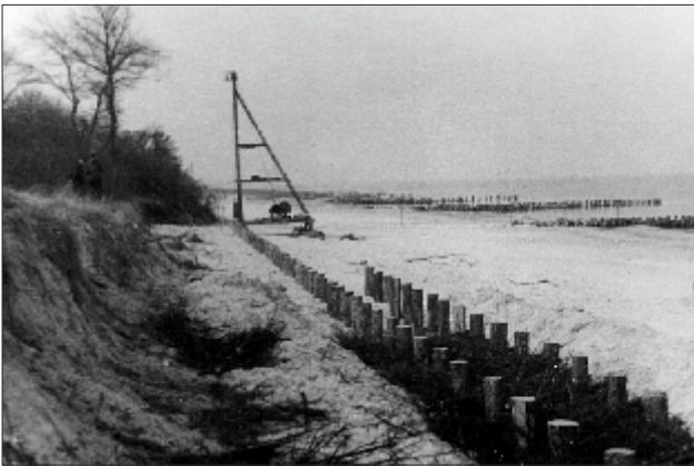
Zabezpieczenie zagrożonych odcinków brzegu morskiego. Coastal protection of the endangered parts of the coast.
