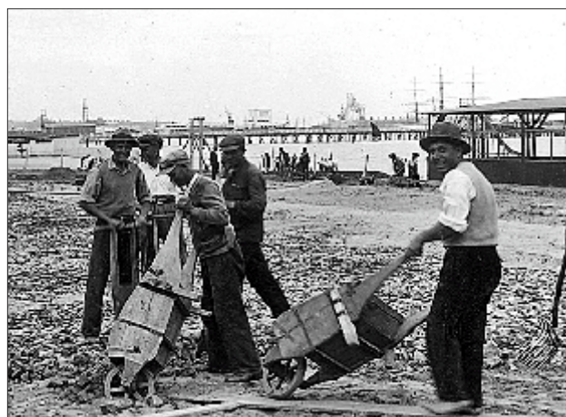
Na budowie portu. Tak rodziła się potęga Gdyni. Building the port, and thus showing how the power of Gdynia was born.
