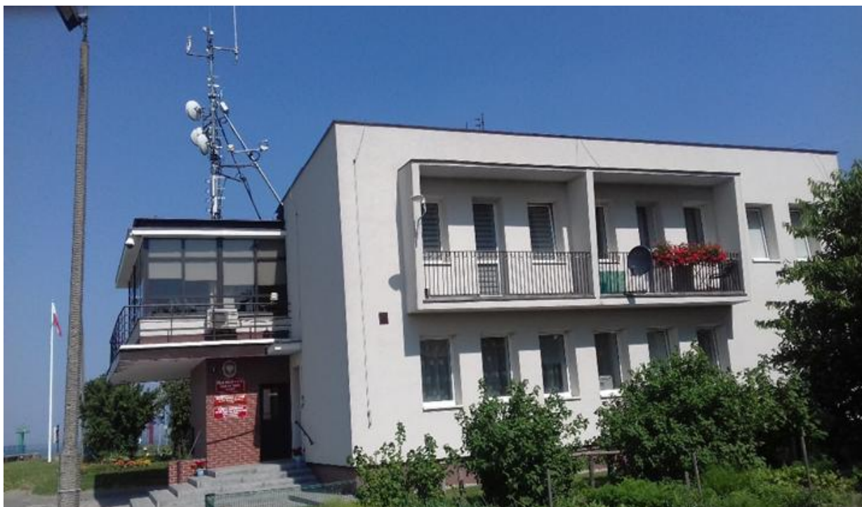
Rys. 3. Frombork port - budynek bosmanatu, lokalizacja stacji RS RTK i nadajnika UHF
