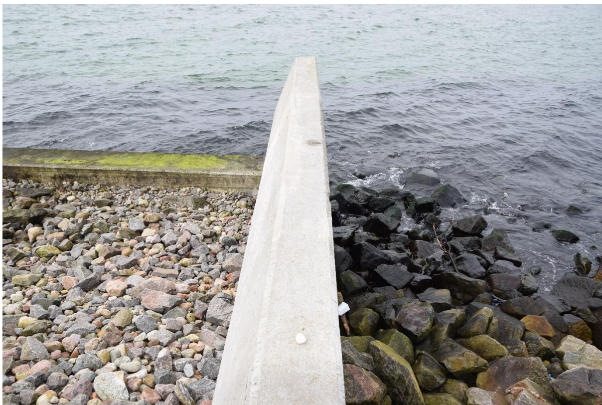
Oczep ścianki szczelnej - widok z góry.
