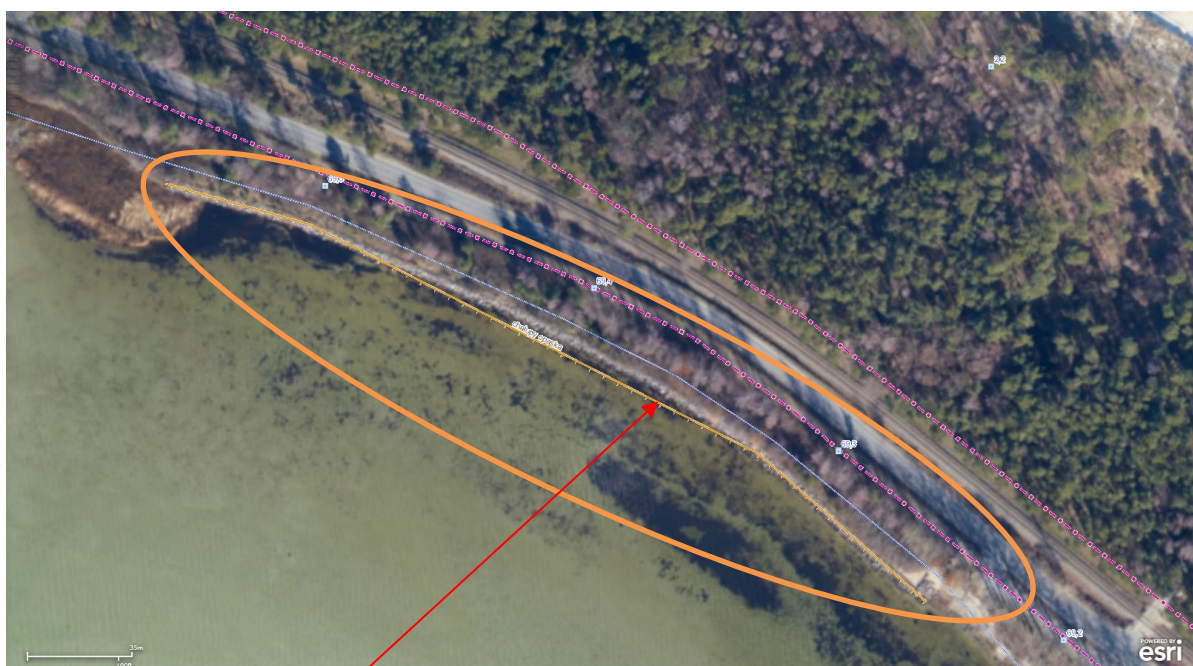
Palisada przeznaczona do naprawy
