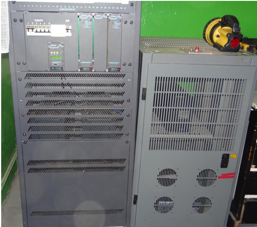
Fot. 7 Szafy UPS
