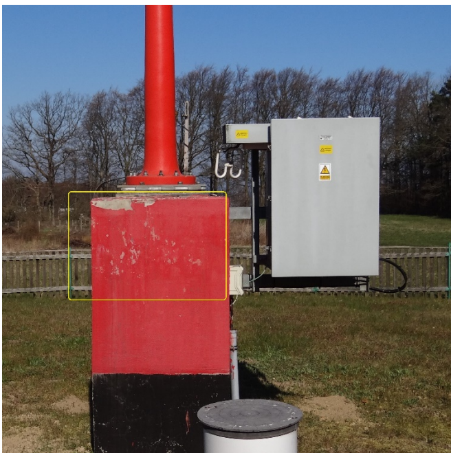
Fot. 2 Fundament masztu nadawczego, skrzynia ATU
