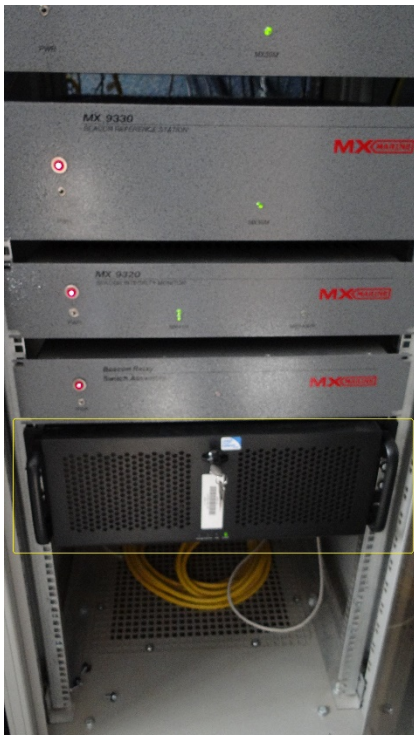
Fot. 6 Rak DGPS, komputer przemysłowy PC – do wymiany
