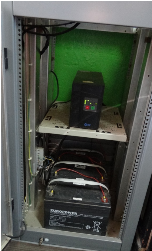
Fot. 5 Szafa UPS urządzeń w raku DGPS, 3x12V, 100Ah.
