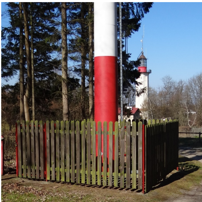
Fot. 3 Płot wieży betonowej
