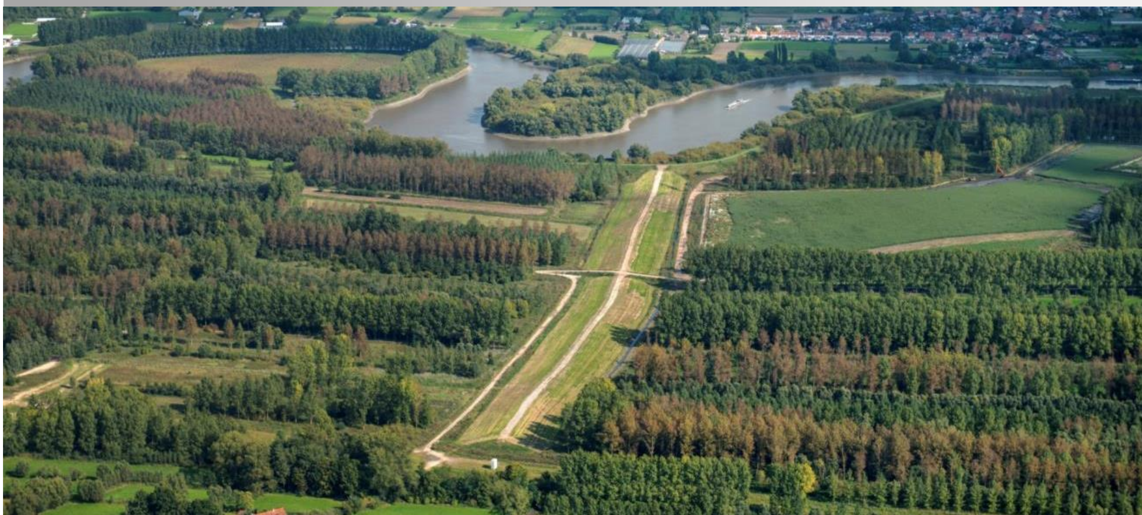
Belgia – Budowa wału powodziowego w Vlassenbroek z powstałej sedymentacji
