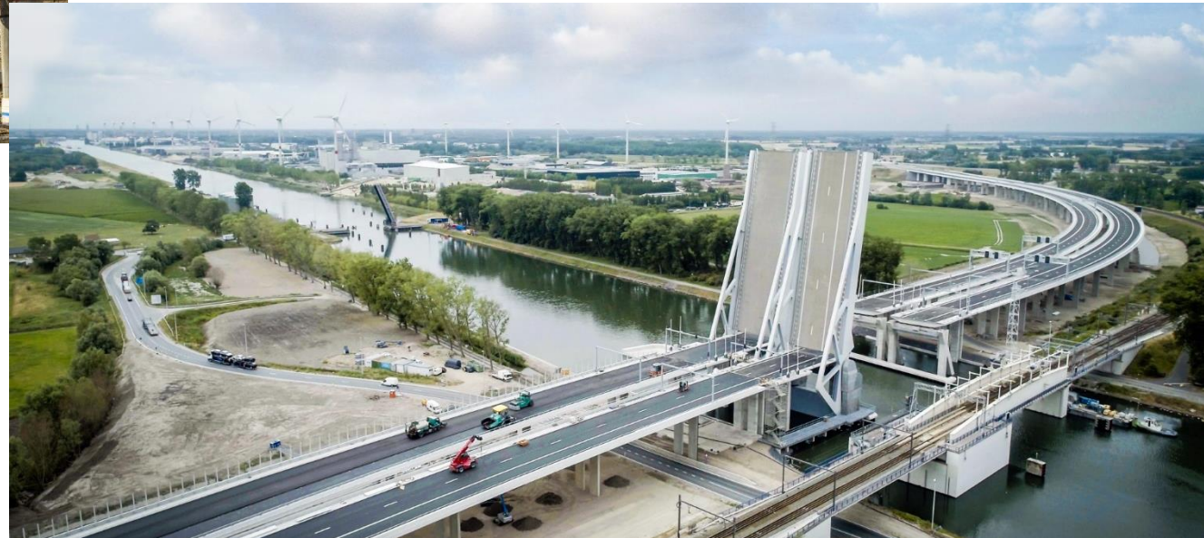
Belgium – Autostrada D11 Brugia-Westkapelle
