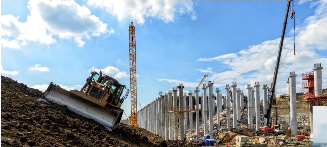
Panama – PSA Rozbudowa Międzynarodowego Terminala Kontenerowego
