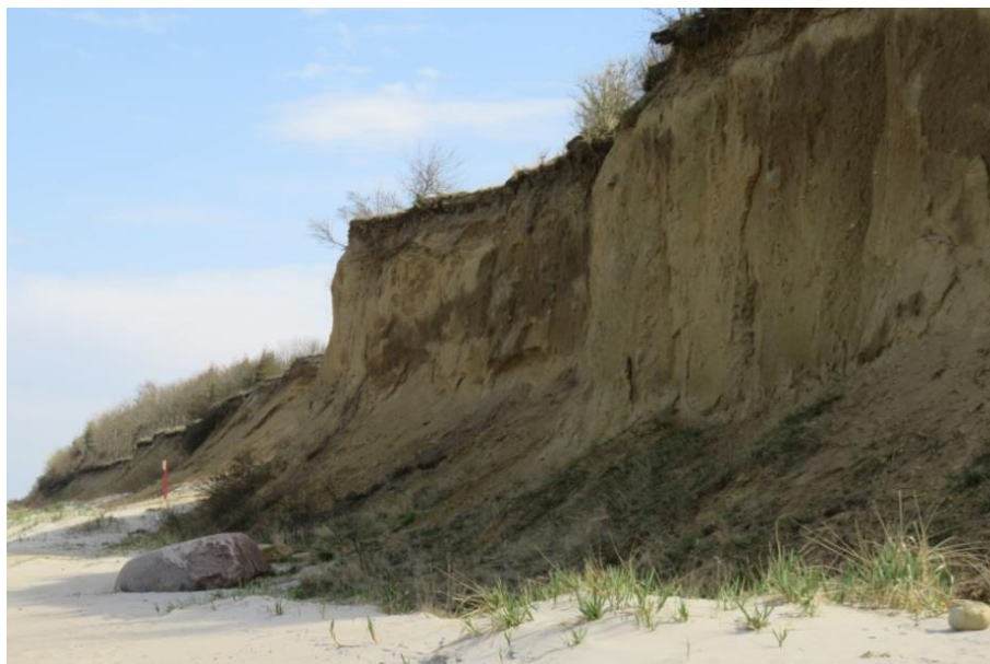
Fotografia 5.4. Fragment aktywnego klifu w rejonie Trzęsacza (H. Boniecka 2016).
