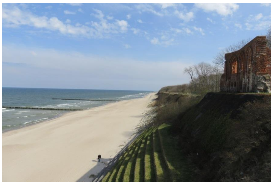
Fotografia 5.11. Wybrzeże klifowe w rejonie Trzęsacza z ochroną stoku klifu i jego podnóża (H. Boniecka 2016).
