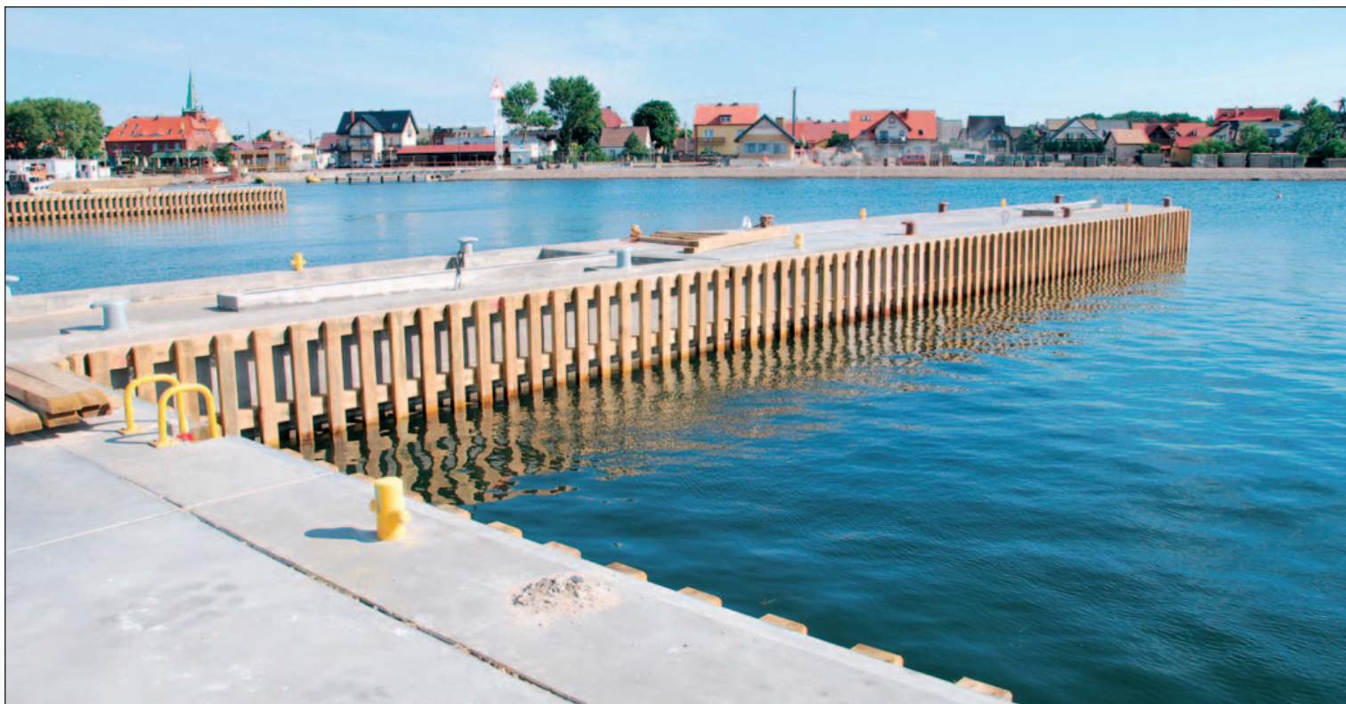
Pirsy postojowe już są prawie gotowe do przyjmowania jednostek. Z archiwum UM w Gdyni. Parking piers are all ready to receive vessels. Photo by courtesy of Gdynia Maritime Office. Landungsbrücken Fast fertig um die Boote aufzunehmen. Foto aus dem Archiv des Seeamtes Gdynia.
