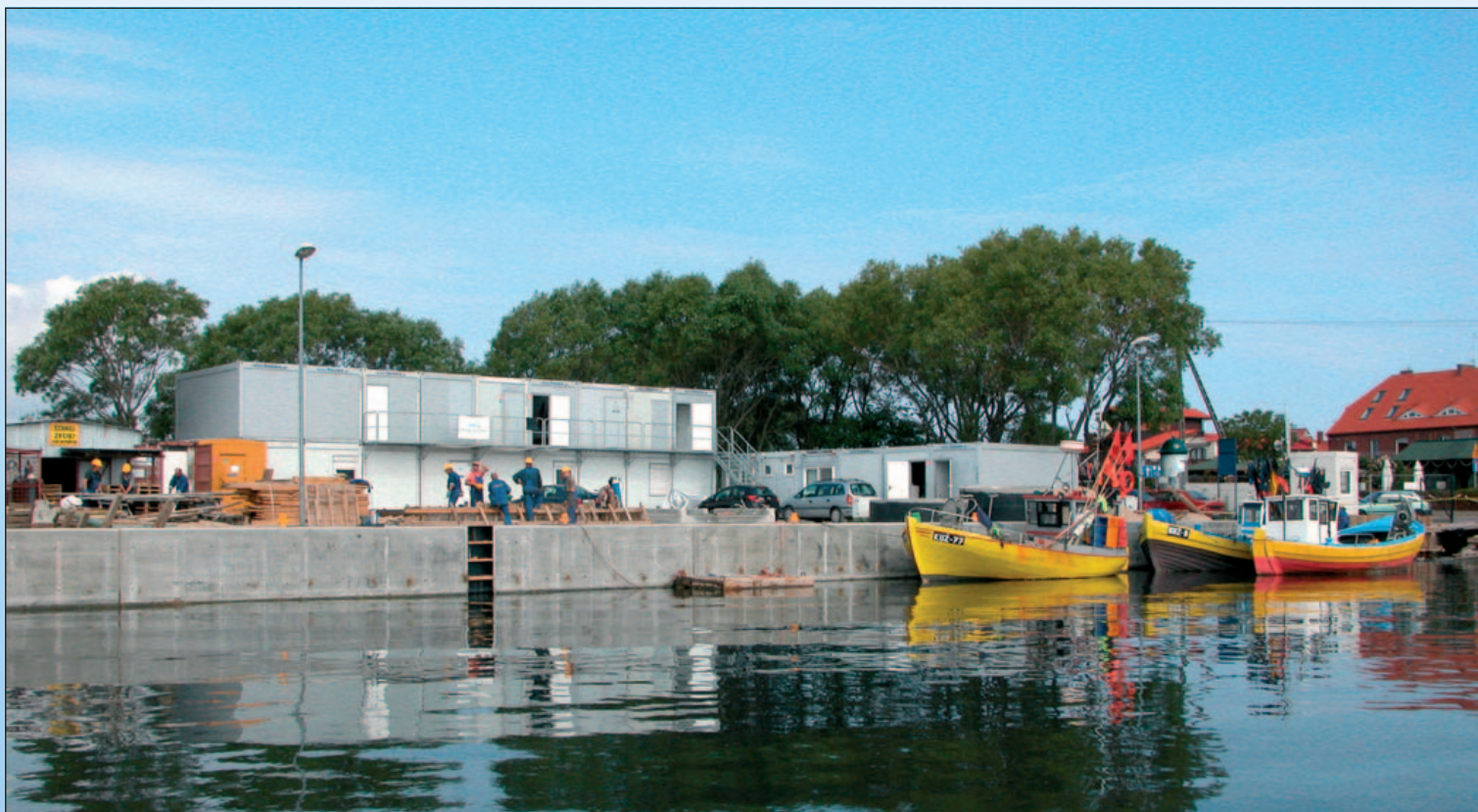
Brygady przygotowują na lądzie prefabrykaty do pirsów. Z archiwum UM w Gdyni. Crews are preparing pier conglomerates on shore. Photo by courtesy of Gdynia Maritime Office. Vorbereitung – am Lande – von Fertigteilen für die Kais. Foto aus dem Archiv des Seeamtes Gdynia.
