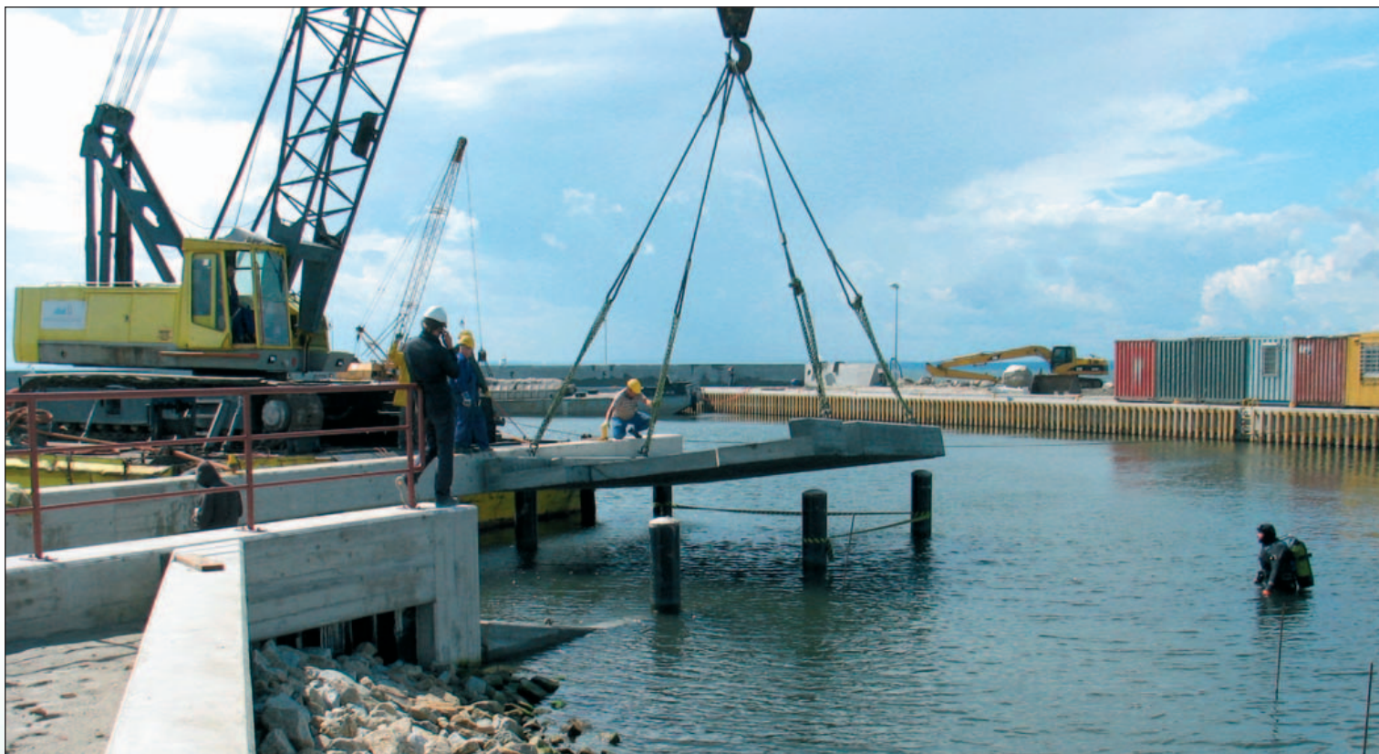
Sierpień 2012 – w układaniu płyt na slapie pomagali płetwonurkowie. Z archiwum UM w Gdyni. August 2012 – the frogmen helped arrange the plates on the slipway. Photo by courtesy of Gdynia Maritime Office. August 2012 – Taucher helfen beim Plattenverlegen am Slip. Foto aus dem Archiv des Seeamtes Gdynia.
