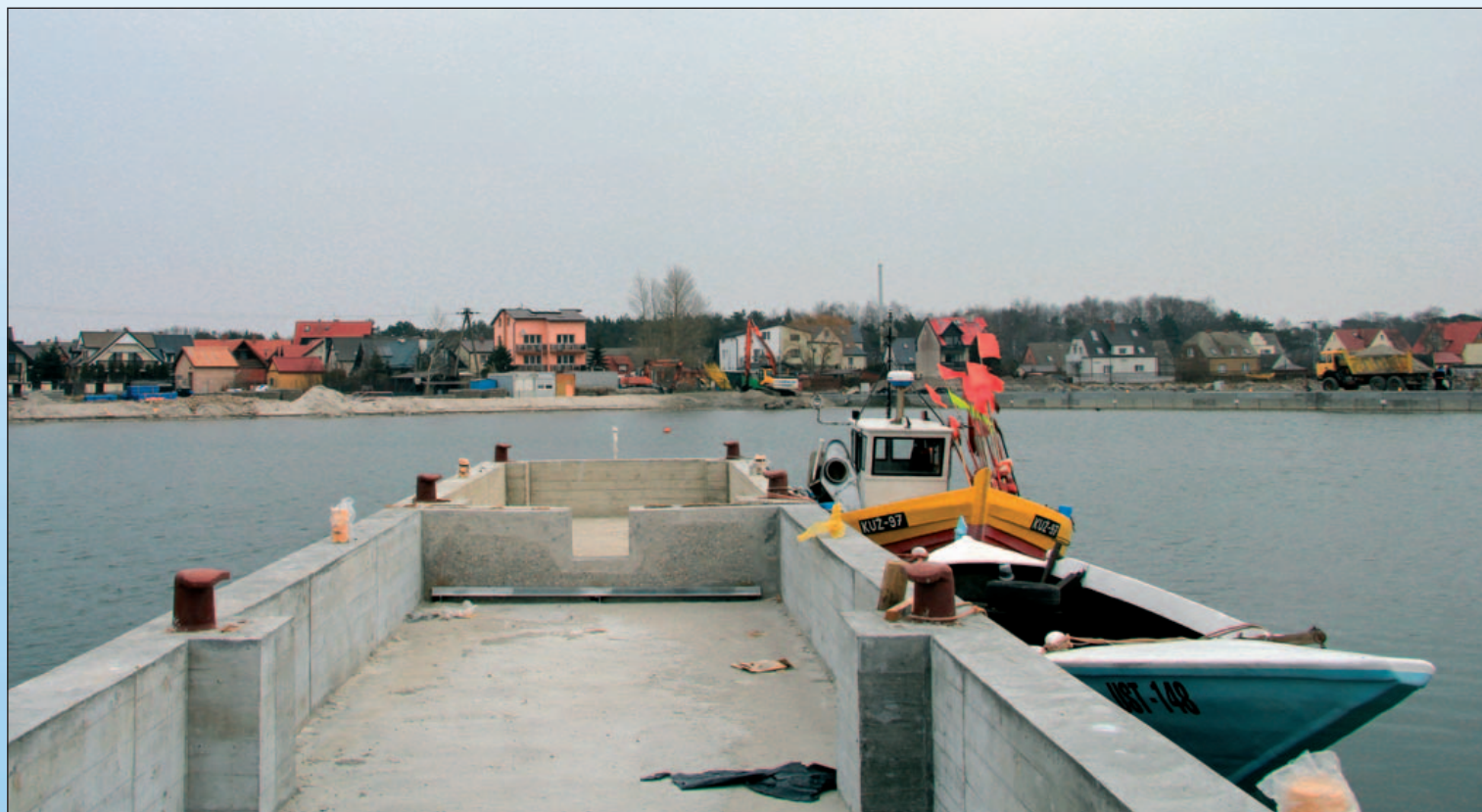
Kwiecień 2012 – tak wygląda płyta i ściany oczepów jednego z pirsów postojowych. Z archiwum UM w Gdyni. April 2012 – that is the look of the board and the walls of the caps on one of the parking piers. Photo by courtesy of Gdynia Maritime Office. April 2012 – so sieht jetzt einer der Anlegeplätze aus. Foto aus dem Archiv des Seeamtes Gdynia.
