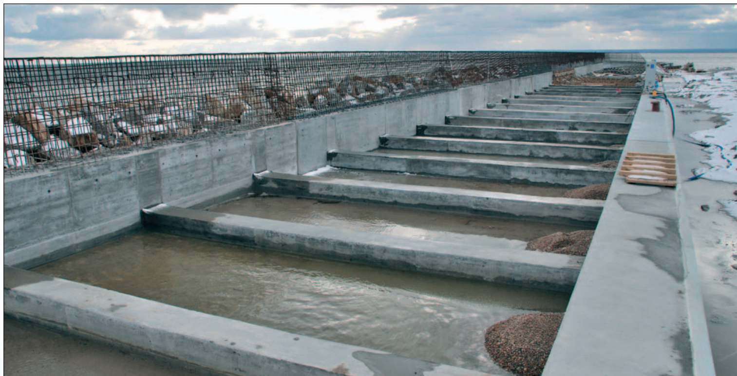
Gotowa płyta z oczepami na falochronie wschodnim. Z archiwum UM w Gdyni. A ready wall with the caps on the eastern breakwater. Photo by courtesy of Gdynia Maritime Office. Fertige östliche Wellenbrecherplatte. Foto aus dem Archiv des Seeamtes Gdynia.
