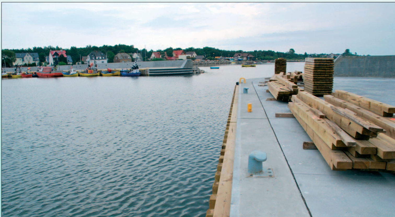
Montaż wyposażenia na pirsie przy falochronie południowym. Z archiwum UM w Gdyni. Assembling the equipment on the pier at the southern breakwater. Photo by courtesy of Gdynia Maritime Office. Montage der Ausrüstung an der Landungsbrücke des südlichen Wellenbrechers. Foto aus dem Archiv des Seeamtes Gdynia.
