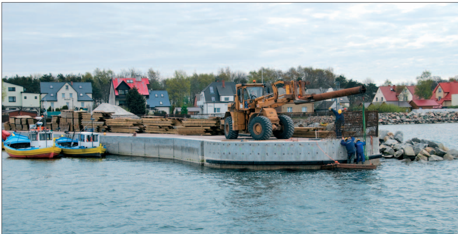
Maj 2012 – brygada podczas montażu kotew do opierzeń głowicy. Nieco dalej – cumujące łodzie. Z archiwum UM w Gdyni. May 2012 – the crew while assembling the anchors to the head's planking. A little further – boats mooring. Photo by courtesy of Gdynia Maritime Office.
