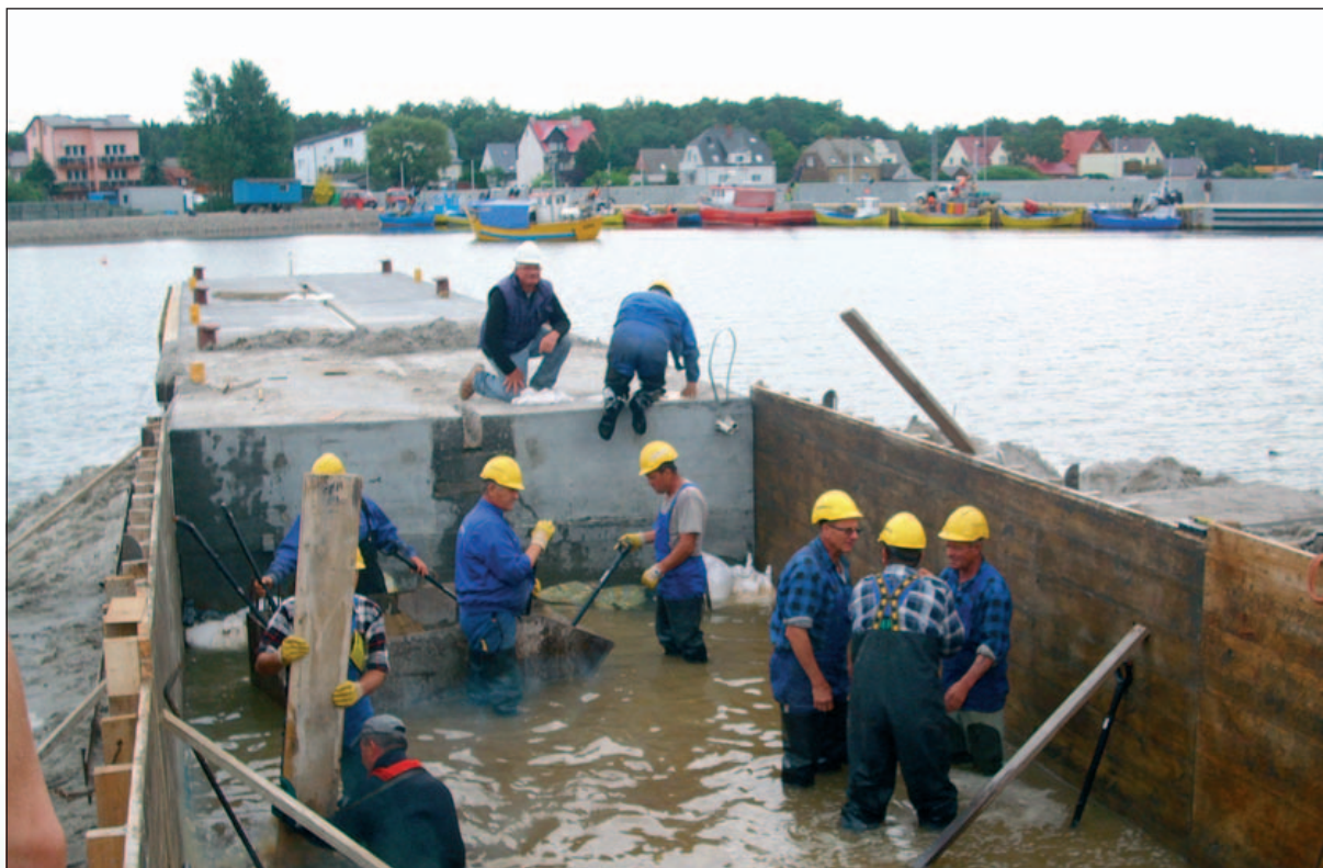
Zbrojenie pirsu przy wysokim stanie wody. Fot. S. Konkel. Reinforcing the pier with a high water level. Photo by S. Konkel. Verstärkung der Landungsbrücke bei hohem Wasser. Foto S. Konkel.
