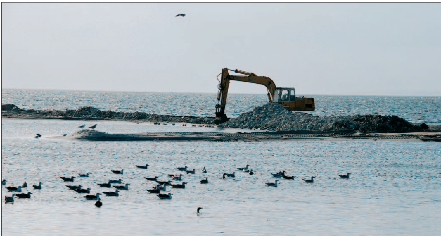
Październik 2011 – roboty podczyszczeniowe na falochronie wschodnim. Z archiwum UM w Gdyni. October 2011 – pretreatment works on the eastern breakwater. Photo by courtesy of Gdynia Maritime Office. Oktober 2011 – Säuberungsarbeiten am östlichen Wellenbrecher. Foto aus dem Archiv des Seeamtes Gdynia.
