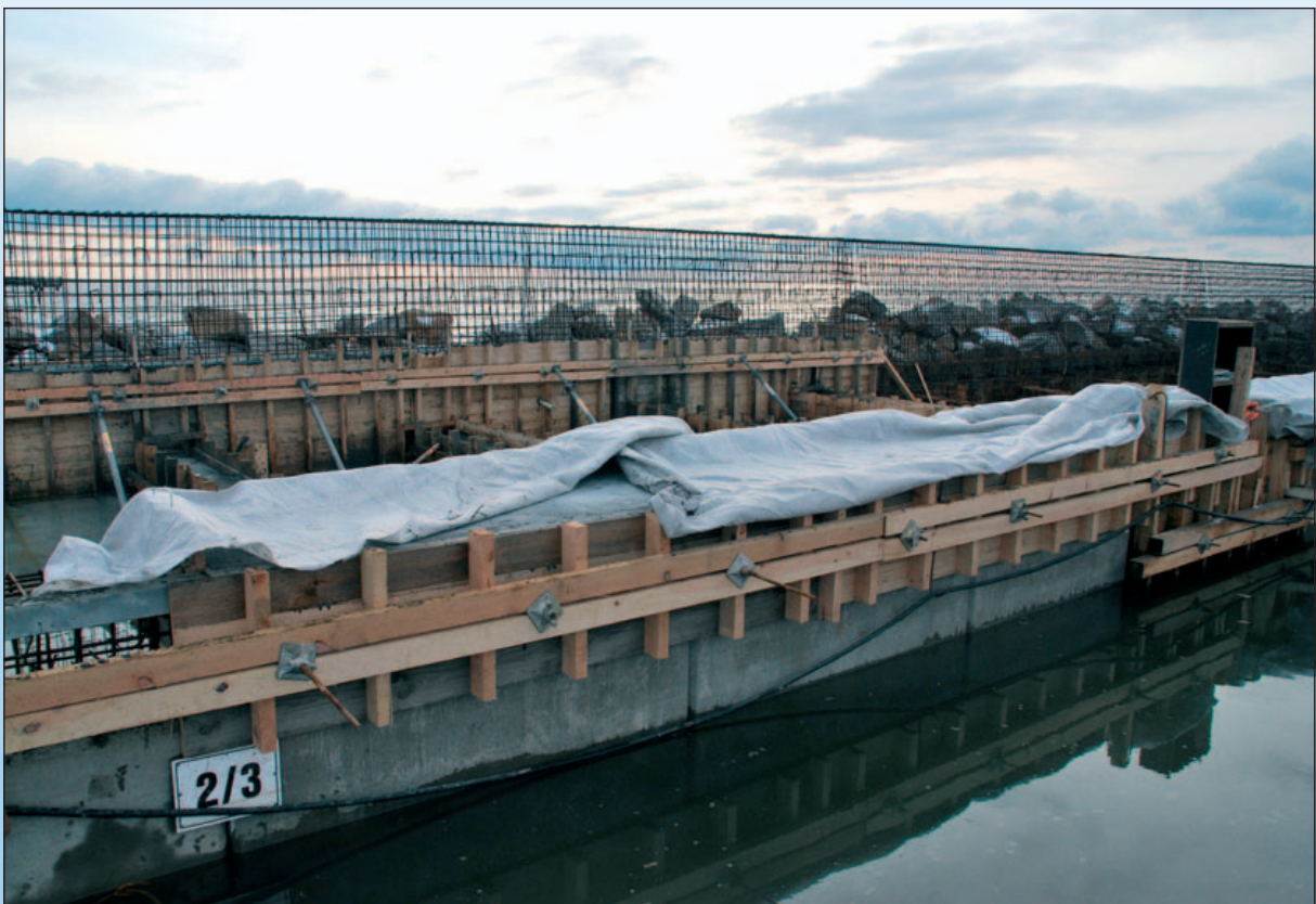
Styczeń 2012 – szalunki ocepów na falochronie wschodnim. Z archiwum UM w Gdyni. January 2012 – shoring the caps on the eastern breakwater. Photo by courtesy of Gdynia Maritime Office. Januar 2012 – Schallungen am östlichen Wellenbrecher. Foto aus dem Archiv des Seeamtes Gdynia.
