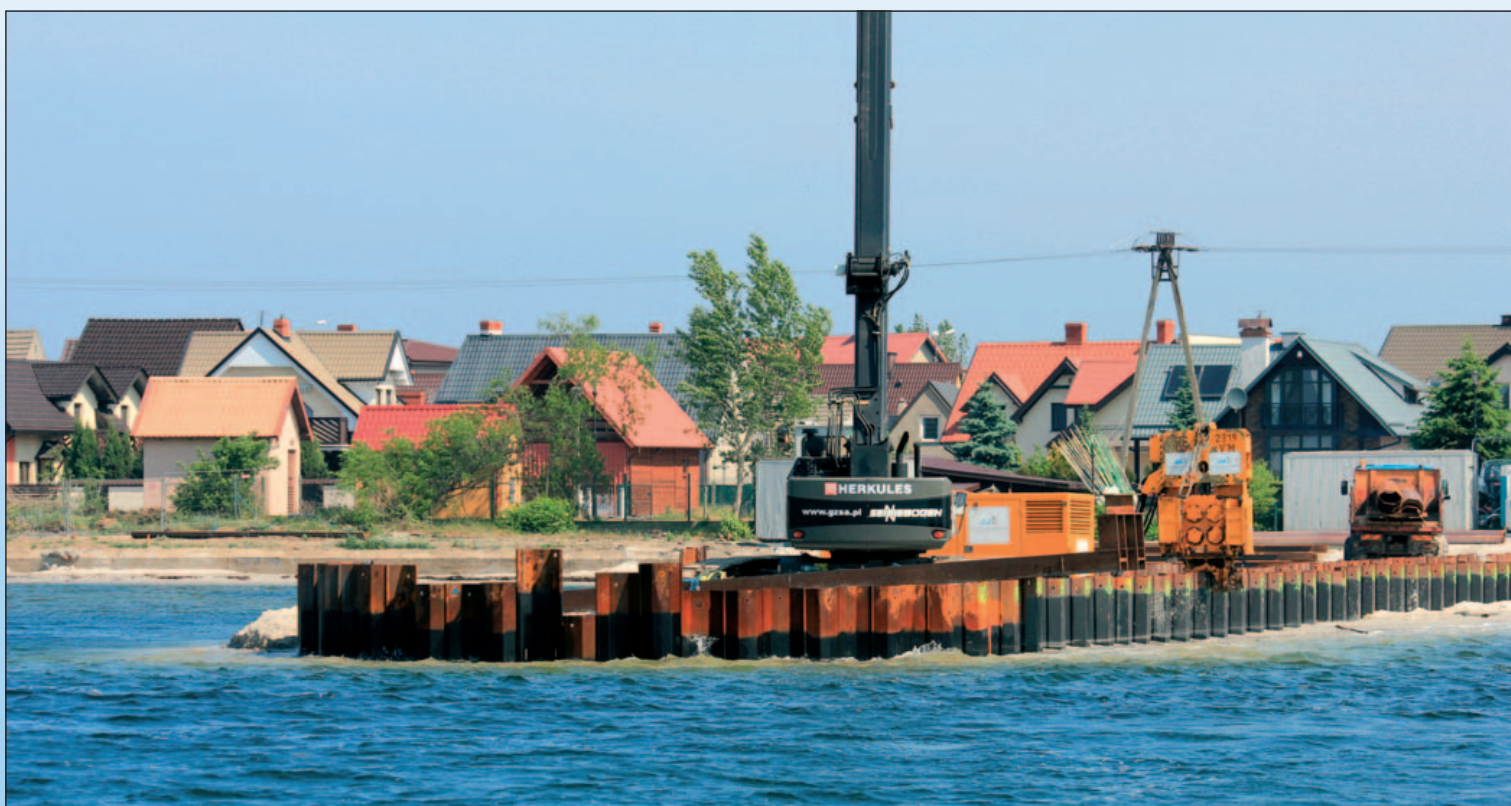
Zaciśnięte szczęki wibromłota na elementach w sąsiedztwie głowicy falochronu wschodniego. Z archiwum UM w Gdyni.
