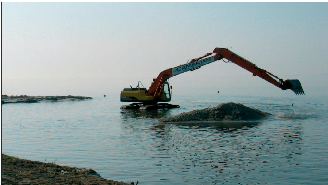
Taki był początek budowy w pierwszych miesiącach 2011 roku. Z archiwum UM w Gdyni. That was the building's beginning in the first months of the year 2011. Photo by courtesy of Gdynia Maritime Office. So war der Beginn des Baus in den ersten Monaten 2011. Foto aus dem Archiv des Seeamtes Gdynia.
