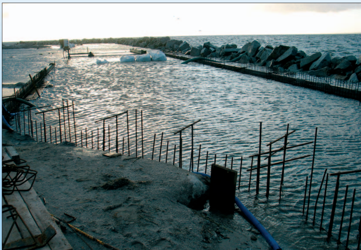
Zalane konstrukcje falochronu przy wysokim stanie wody. Z archiwum UM w Gdyni. Flooded breakwater's framing with a high tide. Photo by courtesy of Gdynia Maritime Office. Abgetauchte Konstruktion des Wellenbrechers bei hohem Wasser. Foto aus dem Archiv des Seamtes Gdynia.
