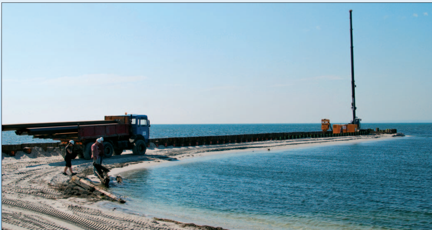
Herkules kończy wbijanie brusów w rejonie głowicy falochronu. Z archiwum UM w Gdyni. The Hercule is finishing nailing the matchboard in the area of the breakwater head. Photo by courtesy of Gdynia Maritime Office. Herkules beendet die Planken-Einsatzung im Bereich des Wellenbrecherkopfes. Foto aus dem Archiv des Seeamtes Gdynia.
