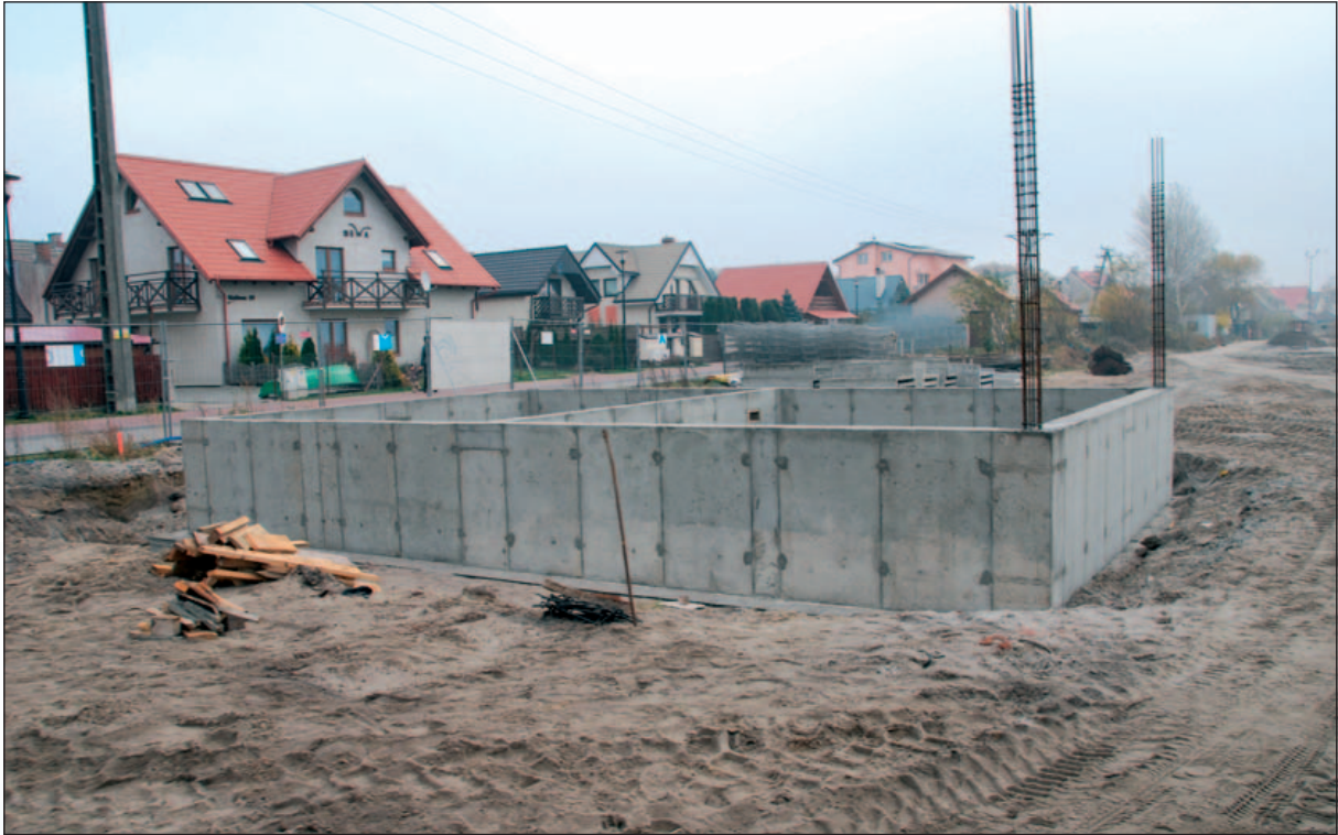
Nowy bosmanat wyrasta z ziemi. Na razie widać ściany fundamentowe. Z archiwum UM w Gdyni. The new bosun's office is emerging. So far, one can see the wall foundations. Photo by courtesy of Gdynia Maritime Office. Das neue Bootsmann-Amt wächst aus dem Boden. Vorläufig sind nur die Fundamente zu sehen. Foto aus dem Archiv des Seeamtes Gdynia.
