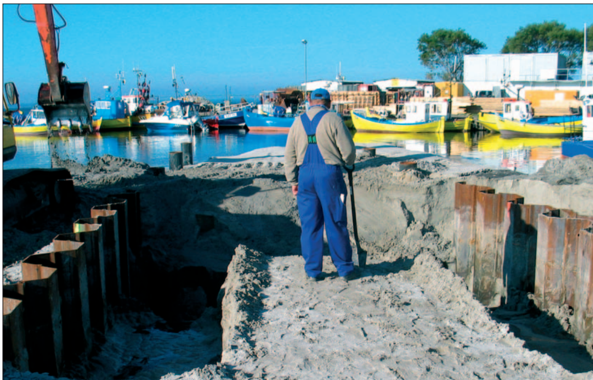
Prace trwały obok cumujących łodzi rybackich. Z archiwum UM w Gdyni. The work in progress near the moored fishing boats. Photo by courtesy of Gdynia Maritime Office. Arbeiten dauerten neben den anliegenden Fischerbooten. Foto aus dem Archiv des Seeamtes Gdynia.
