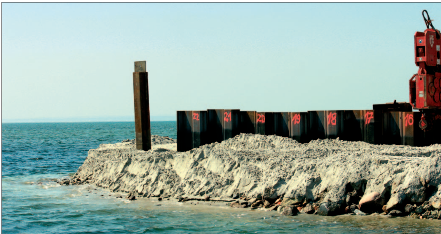
Czerwiec 2011 – pierwsze white pary brusów ścianki szczelnej. Z archiwum UM w Gdyni.
