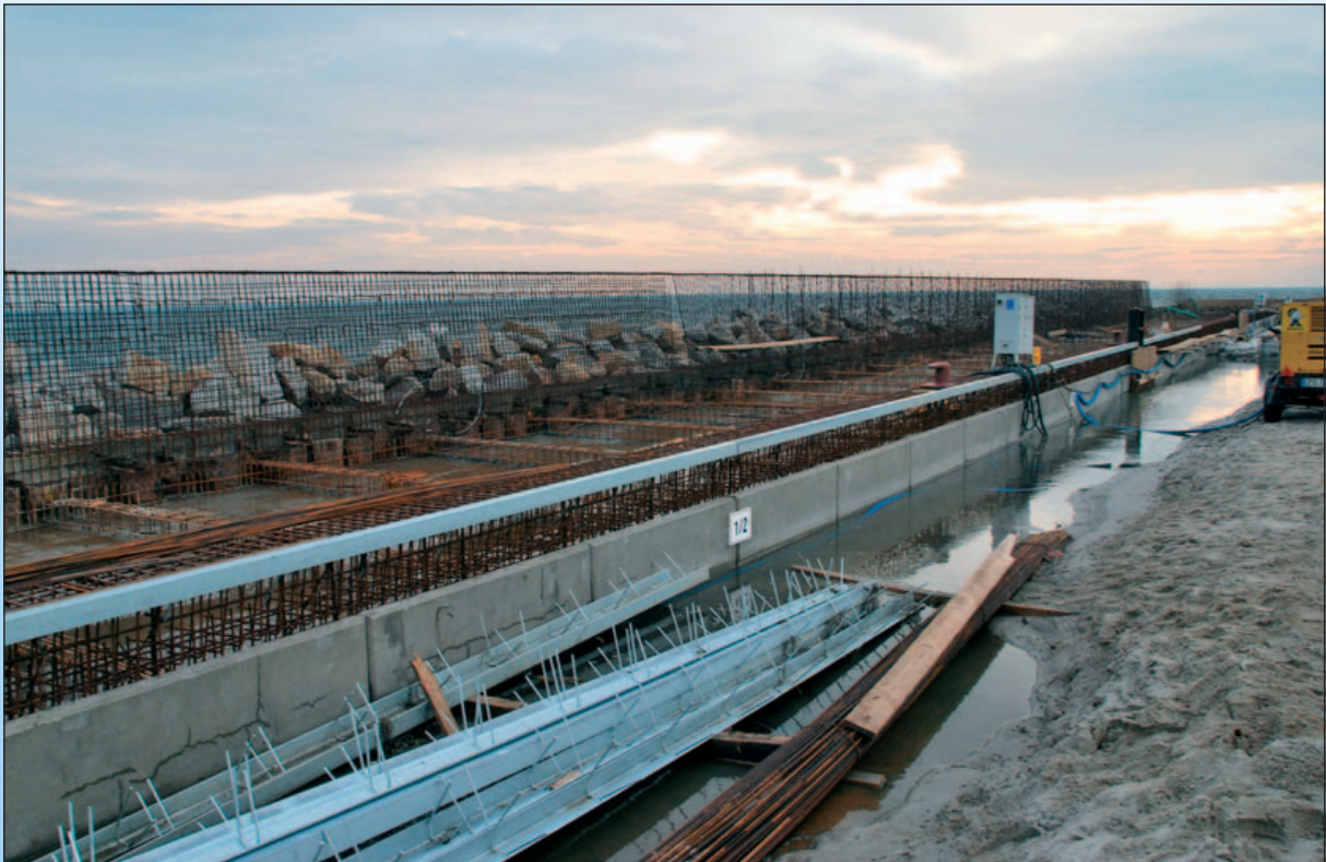
Grudzień 2011 – zbrojenie płyty, oczepu i parapetu falochronu wschodniego. Z archiwum UM w Gdyni. December 2011 – Reinforcing the wall, the cap and the rail of the eastern breakwater. Photo by courtesy of Gdynia Maritime Office. Dezember 2011 – Verstärkungsarbeiten am östlichen Wellenbrecher. Foto aus dem Archiv des Seeamtes Gdynia.
