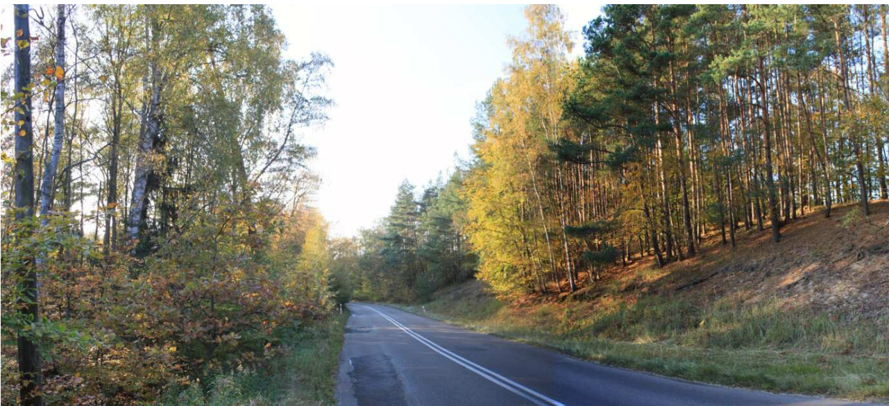
Fot. 12 Droga wojewódzka nr 501 i jej otoczenie (fot. M. Przewoźniak).
