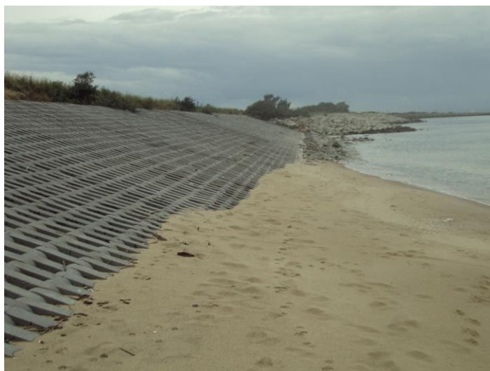
Fot.5 Zwązająca się plaża na zakończeniu opaski narzutowej w rejonie ujścia
