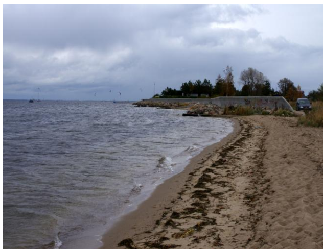
Fot.26 Fragment naturalnego brzegu w Rewie. W oddali widoczny mur oporowy. (fot. Michałek M.)
