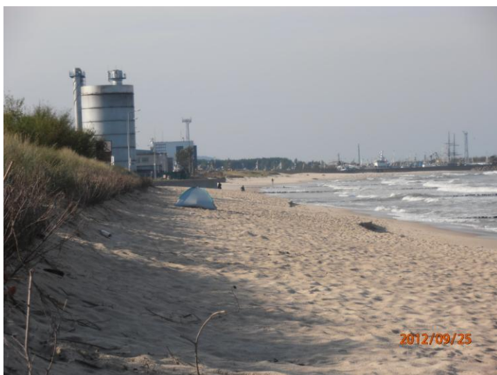
Fot.17 Brzeg morski w rejonie Energobalticu (Władysławowo-wejście na plażę nr 2)
