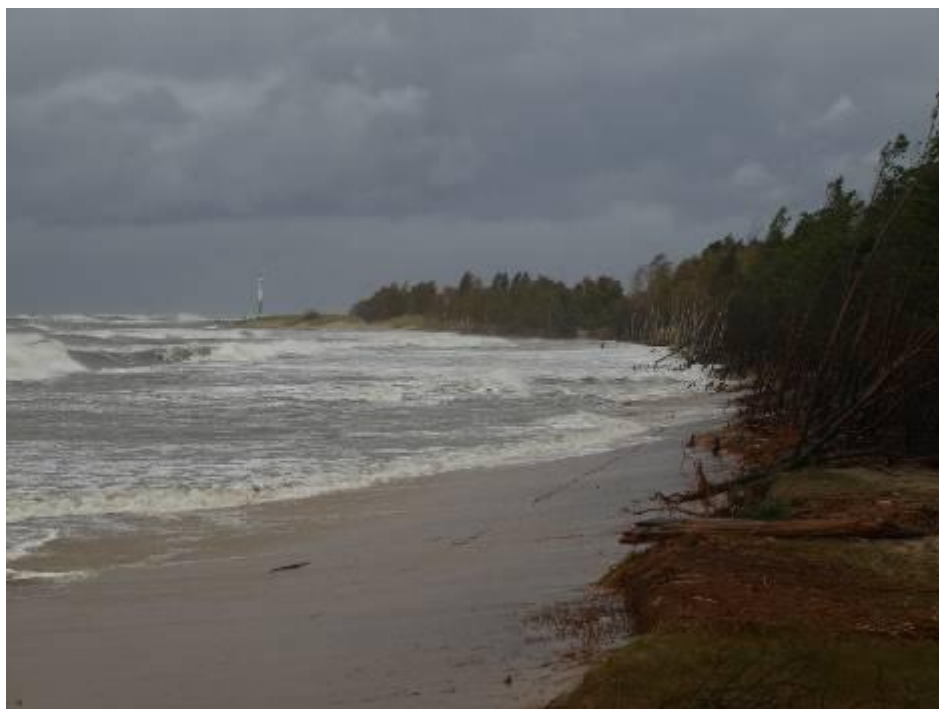
Fot. 3.2. Niszczony brzeg po zachodniej stronie ujścia Śmiałej Wisły (Fot. P. Przedziecki, październik 2009)
