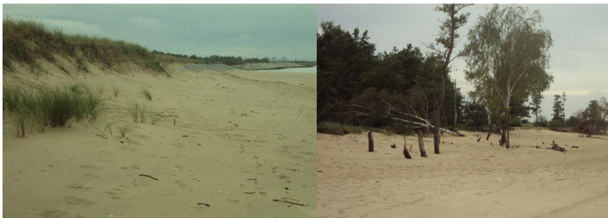
Fot. 3.1. Podcięta wydma na zakończeniu opaski brzegowej w rejonie ujścia (Górki Wschodnie)
