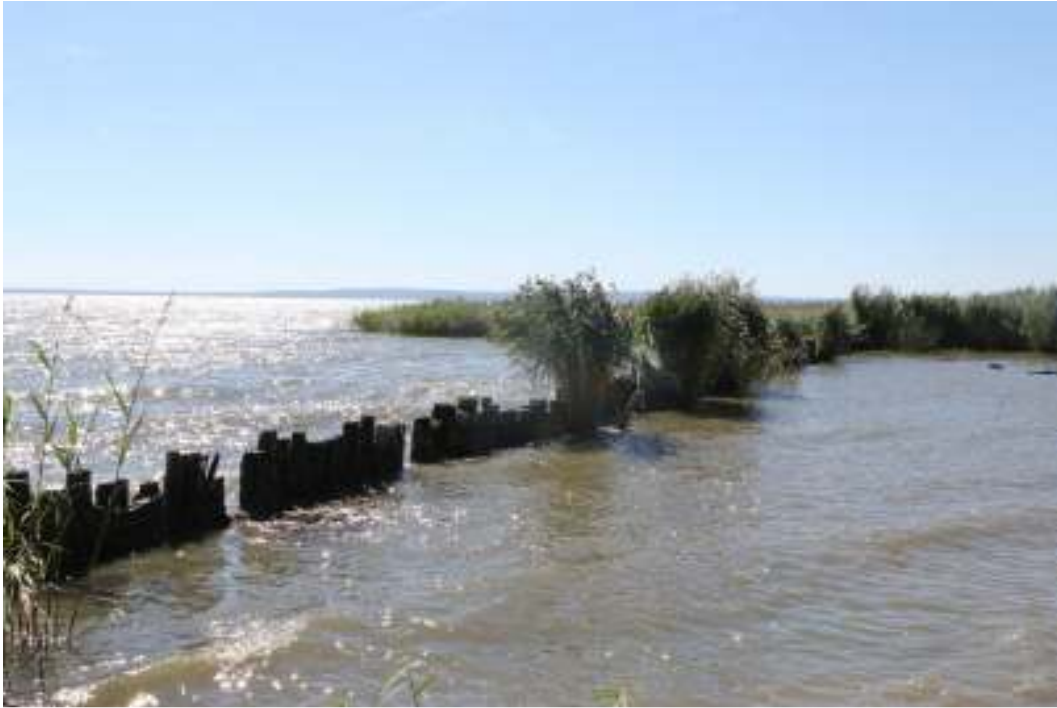
Rys. 7. Częściowo zniszczona palisada drewniana po zachodniej stronie portu
