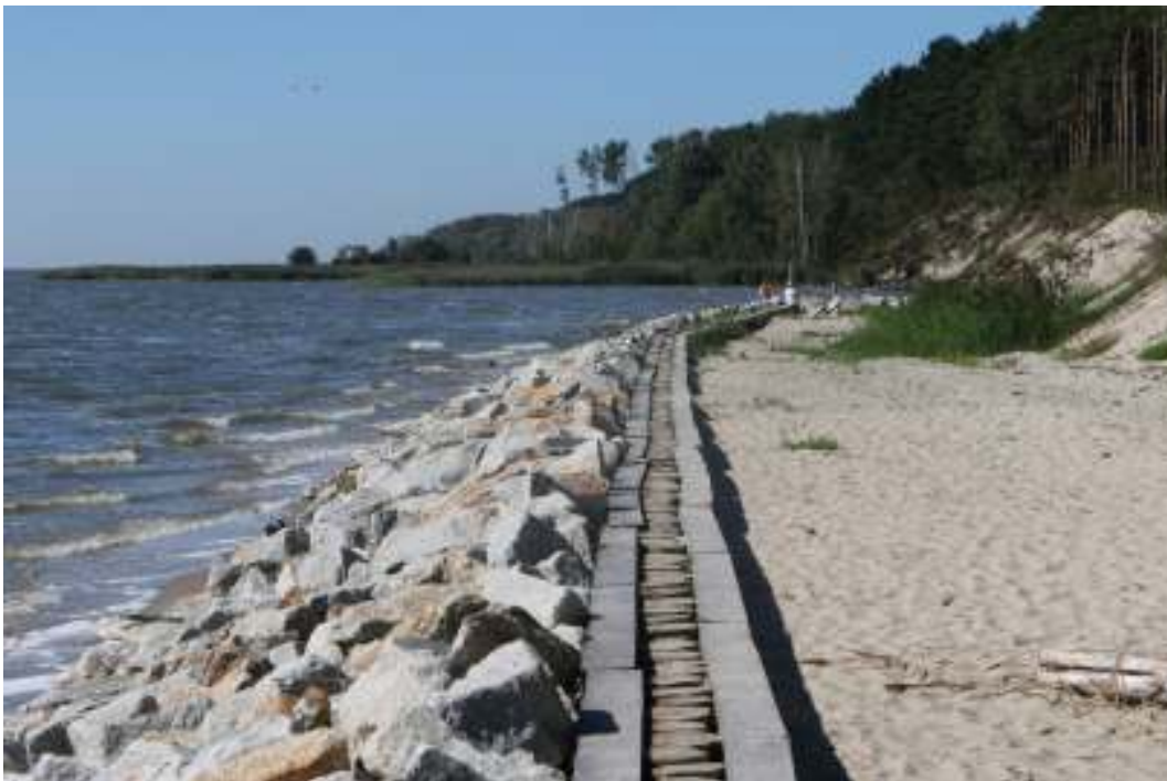
Rys. 8. Opaska brzegowa usytuowana na zachód od portu
