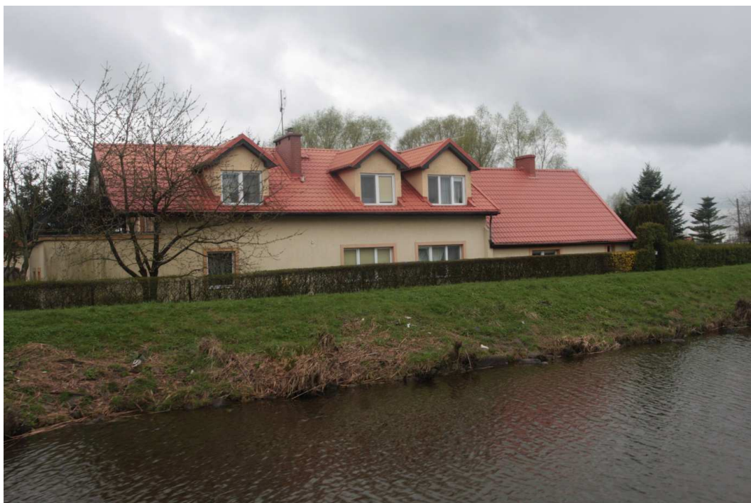
Fot. 12. Pojedyncze zabudowania bezpośrednio sąsiadujące z wałem rzeki Elbląg (rejon Nowakowa)
