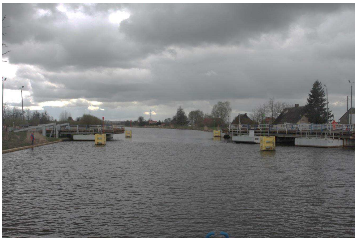
Fot. 11. Most pontonowy w Nowakowie
